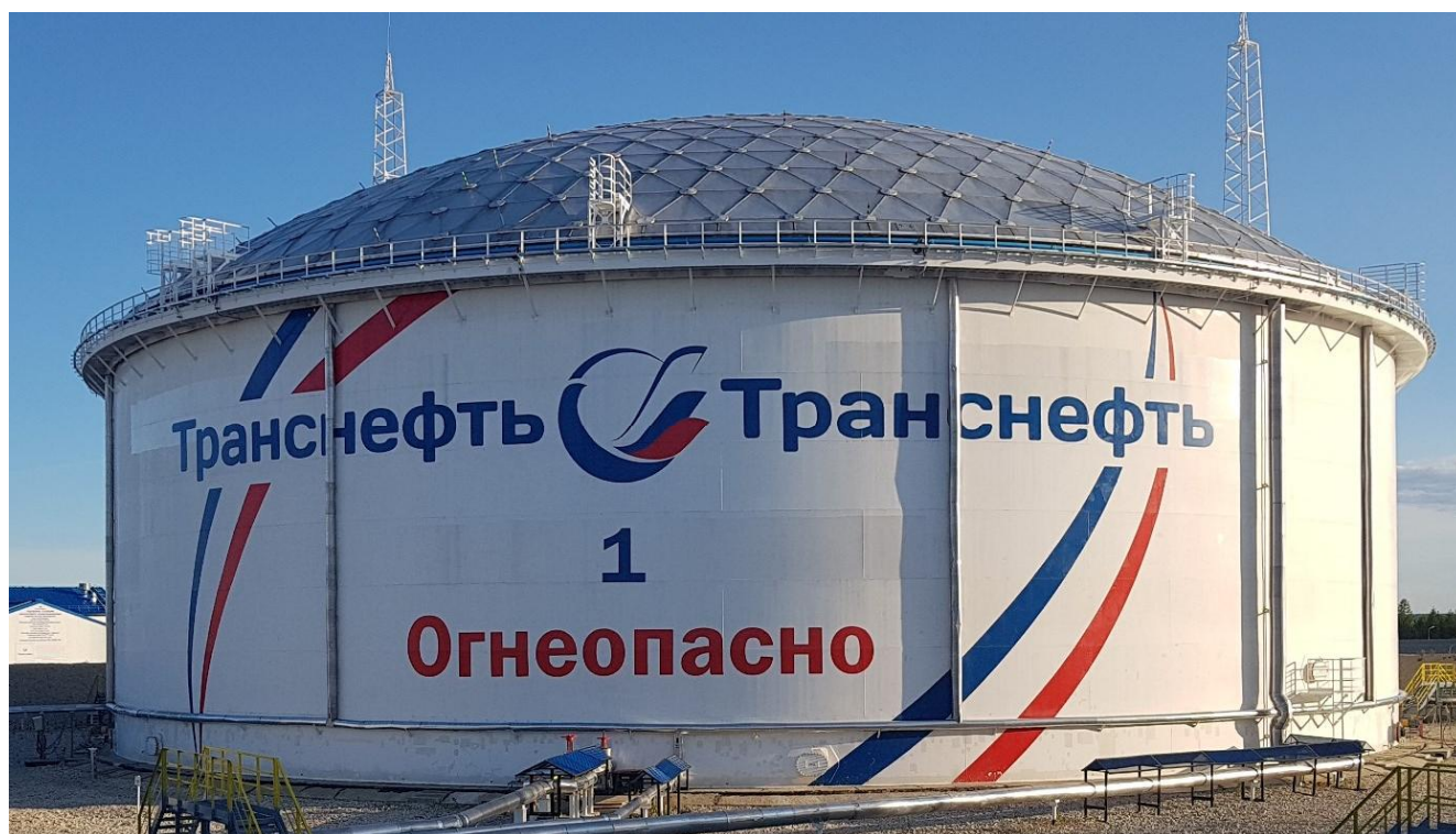
Рисунок 2 - Общий вид резервуара вертикального стального цилиндрического РВСПА-50000
