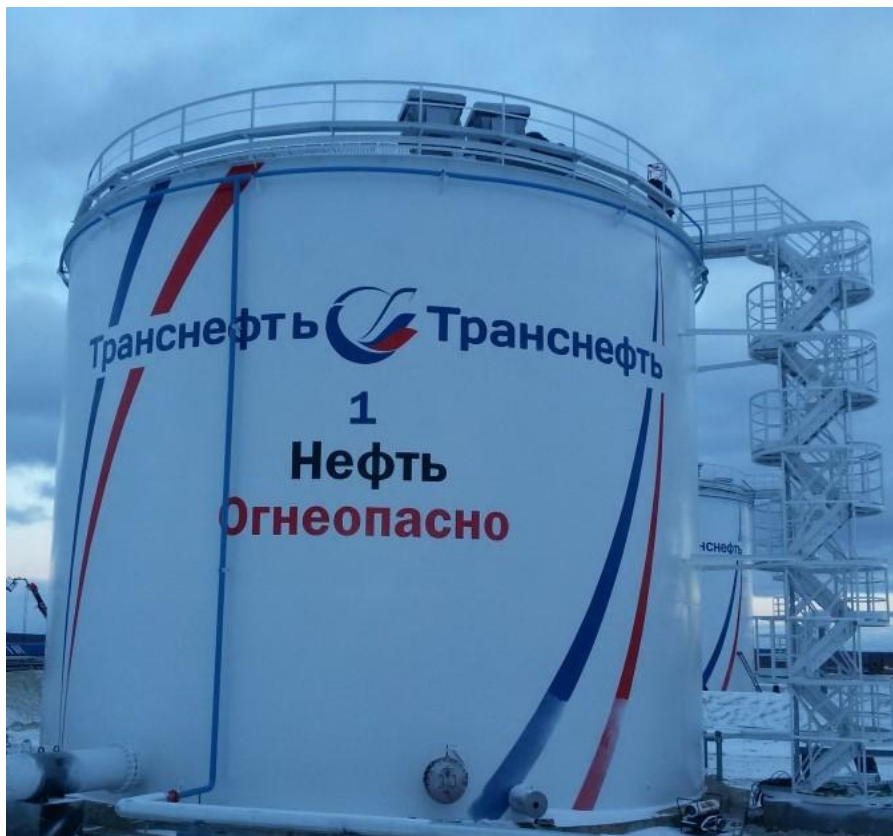
Рисунок 1 - Общий вид резервуаров вертикальных стальных цилиндрических РВС-2000
