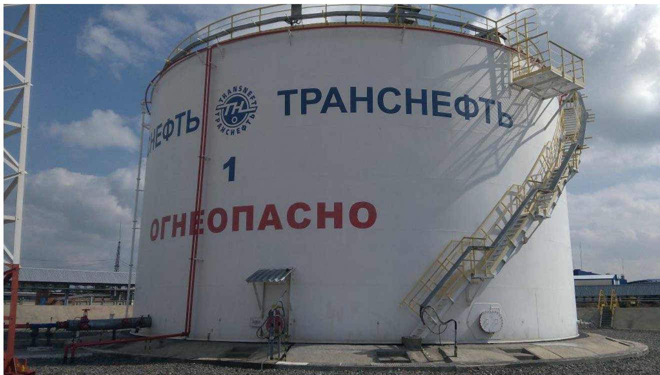
Рисунок 1 - Общий вид резервуара вертикального стального цилиндрического РВС-5000
