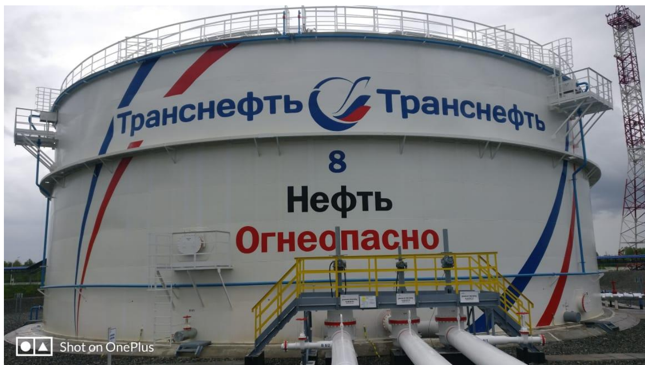
Рисунок 3 - Общий вид резервуара вертикального стального цилиндрического РВСП-10000
