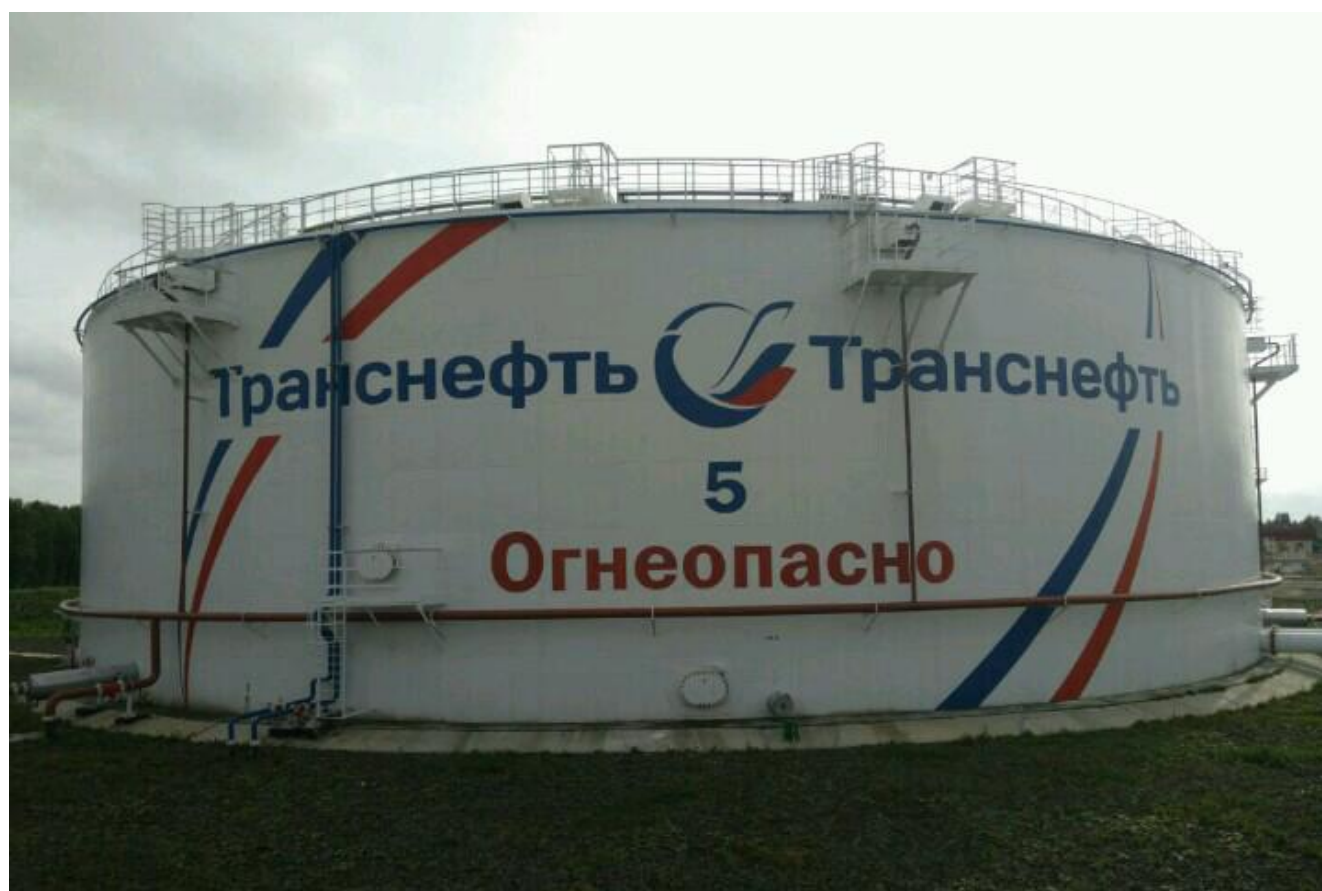
Рисунок 4 - Общий вид резервуара вертикального стального цилиндрического РВСП-20000
