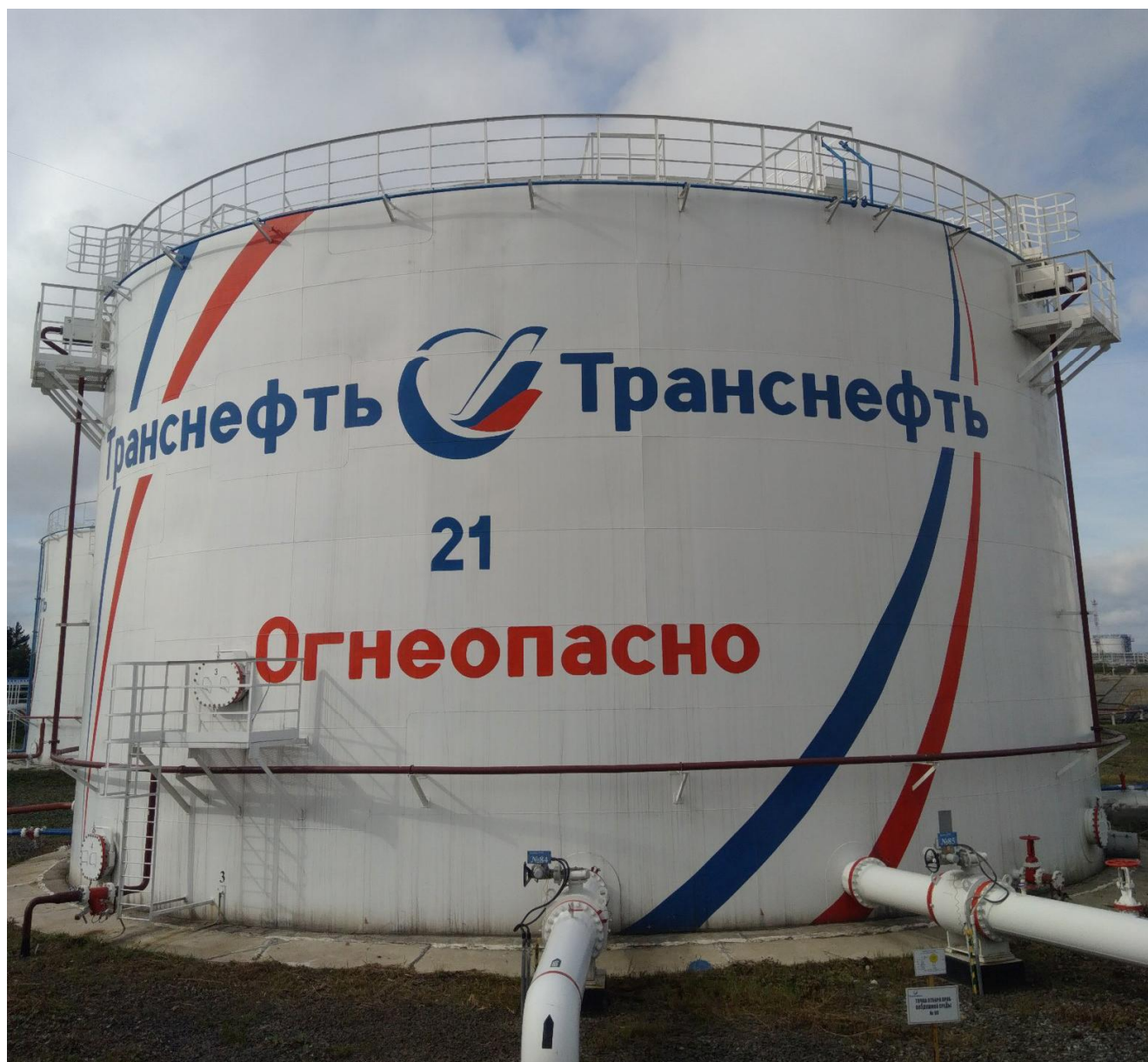
Рисунок 2 - Общий вид резервуара вертикального стального цилиндрического РВСП-5000
