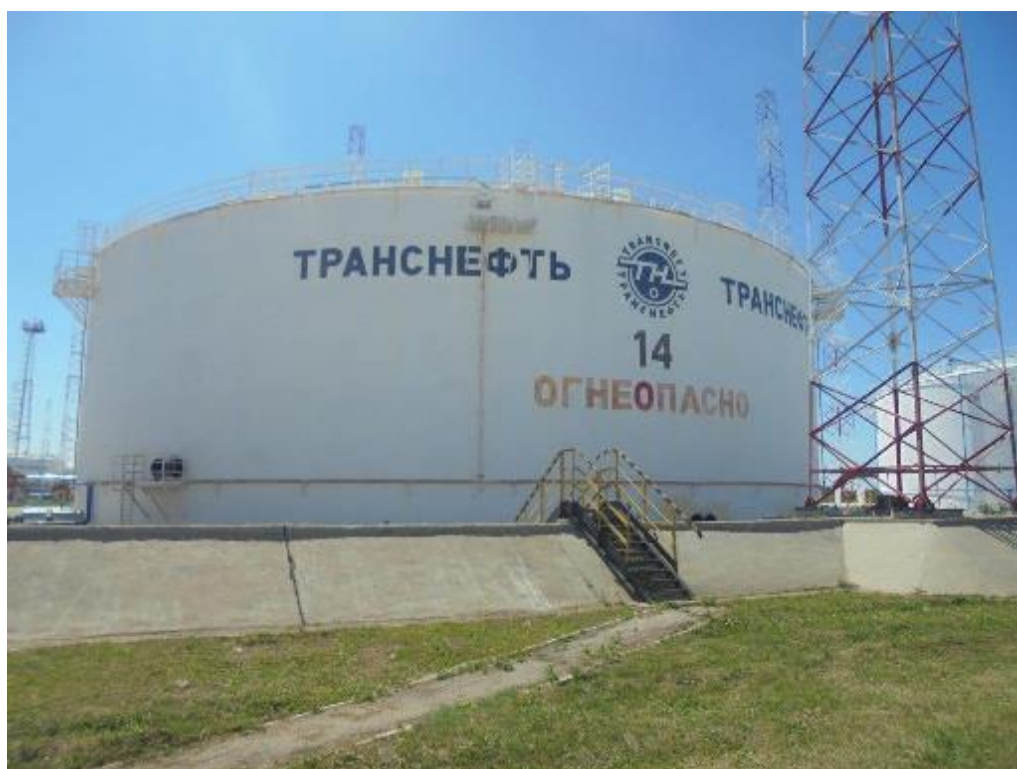
Рисунок 5 - Общий вид резервуара вертикального стального цилиндрического РВСП-20000
