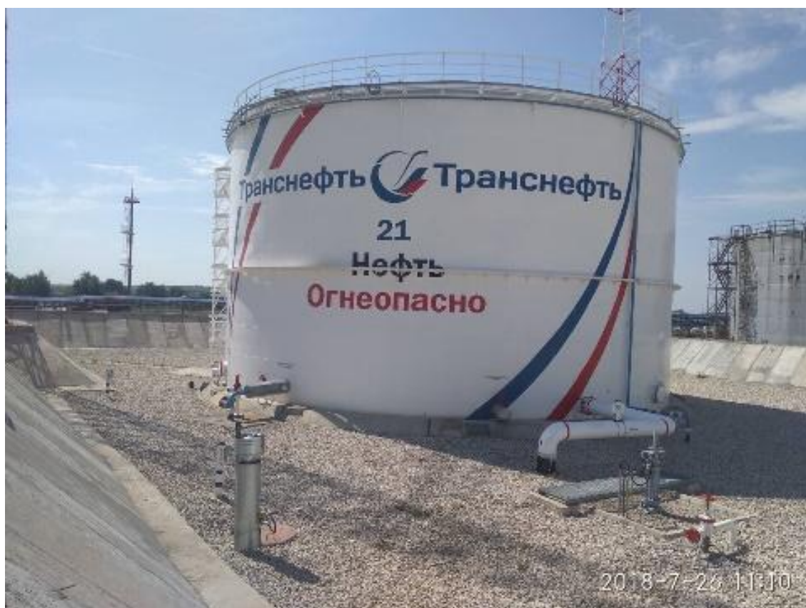
Рисунок 2 - Общий вид резервуара вертикального стального цилиндрического РВС-5000
