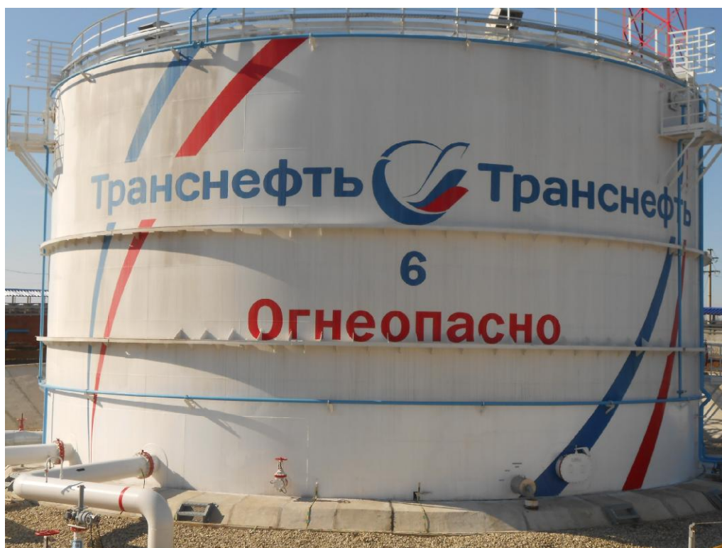
Рисунок 4 - Общий вид резервуара вертикального стального цилиндрического РВСП-5000
