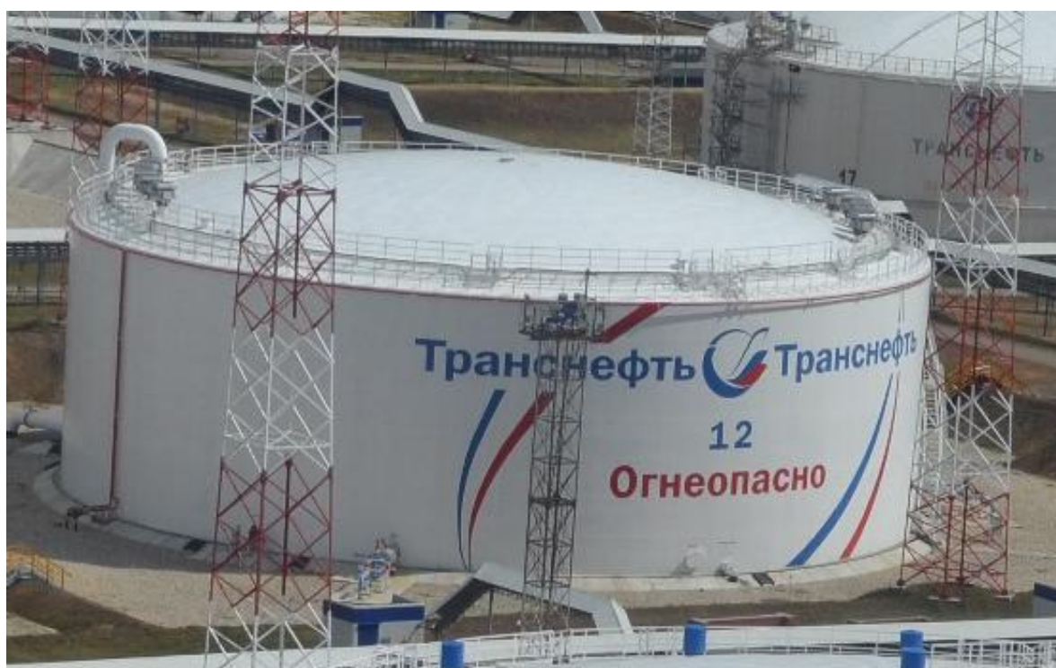
Рисунок 3 - Общий вид резервуара вертикального стального цилиндрического РВС-20000
