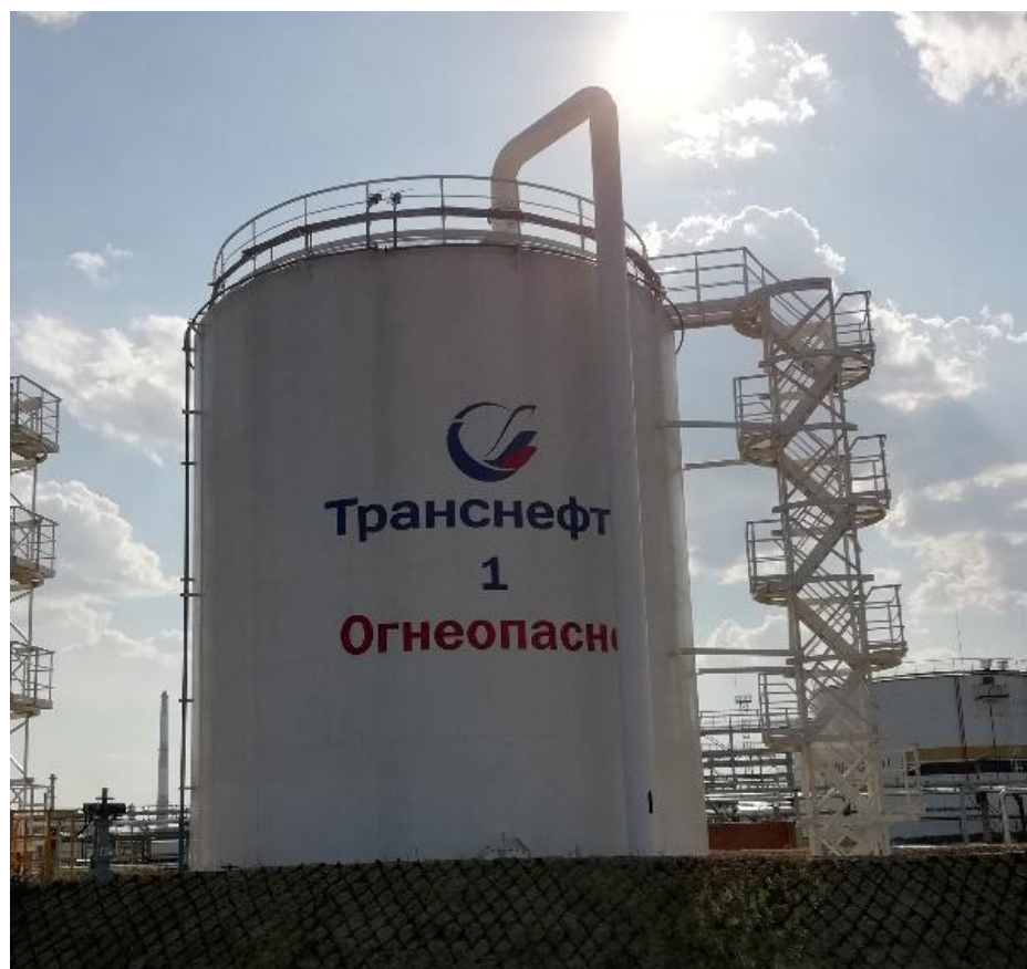
Рисунок 1 - Общий вид резервуара вертикального стального цилиндрического РВС-1000
