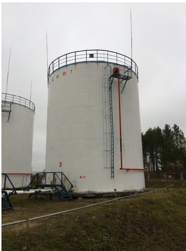
Рисунок 1 - Общий вид резервуара вертикального стального цилиндрического РВС-1000
