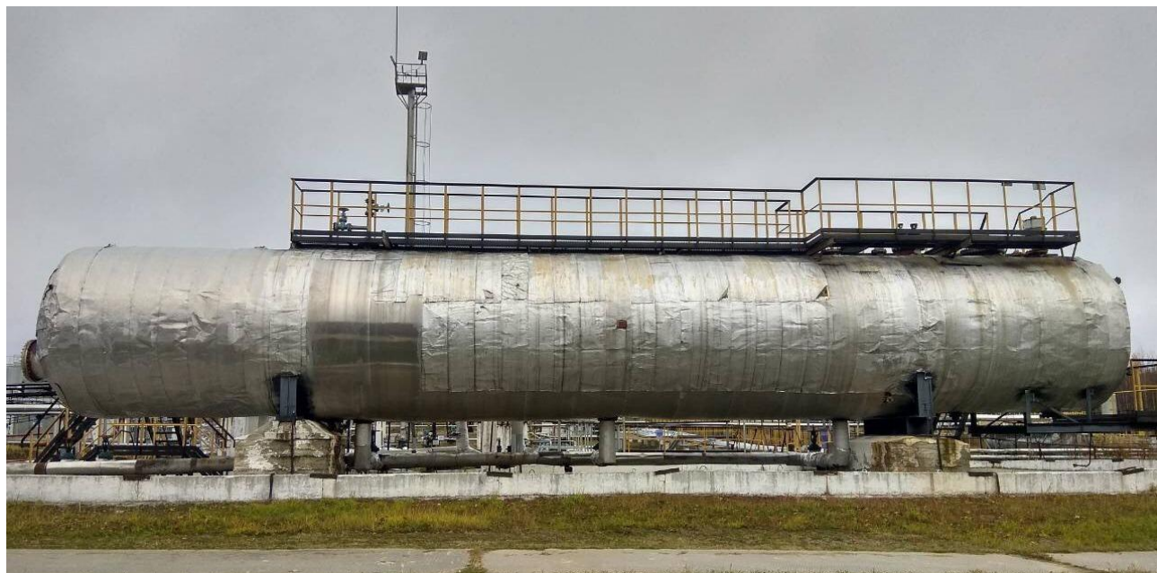
Рисунок 1 - Общий вид резервуара стального горизонтального цилиндрического РГС-200
