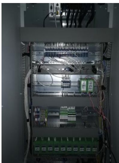
Рисунок 4 - Шкаф аналоговых сигналов
