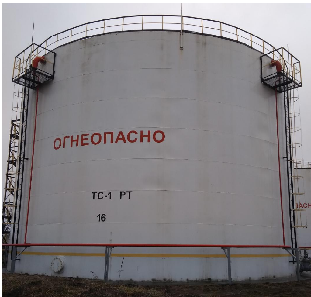
Рисунок 2 - Общий вид резервуара стального вертикального цилиндрического РВС-3000
