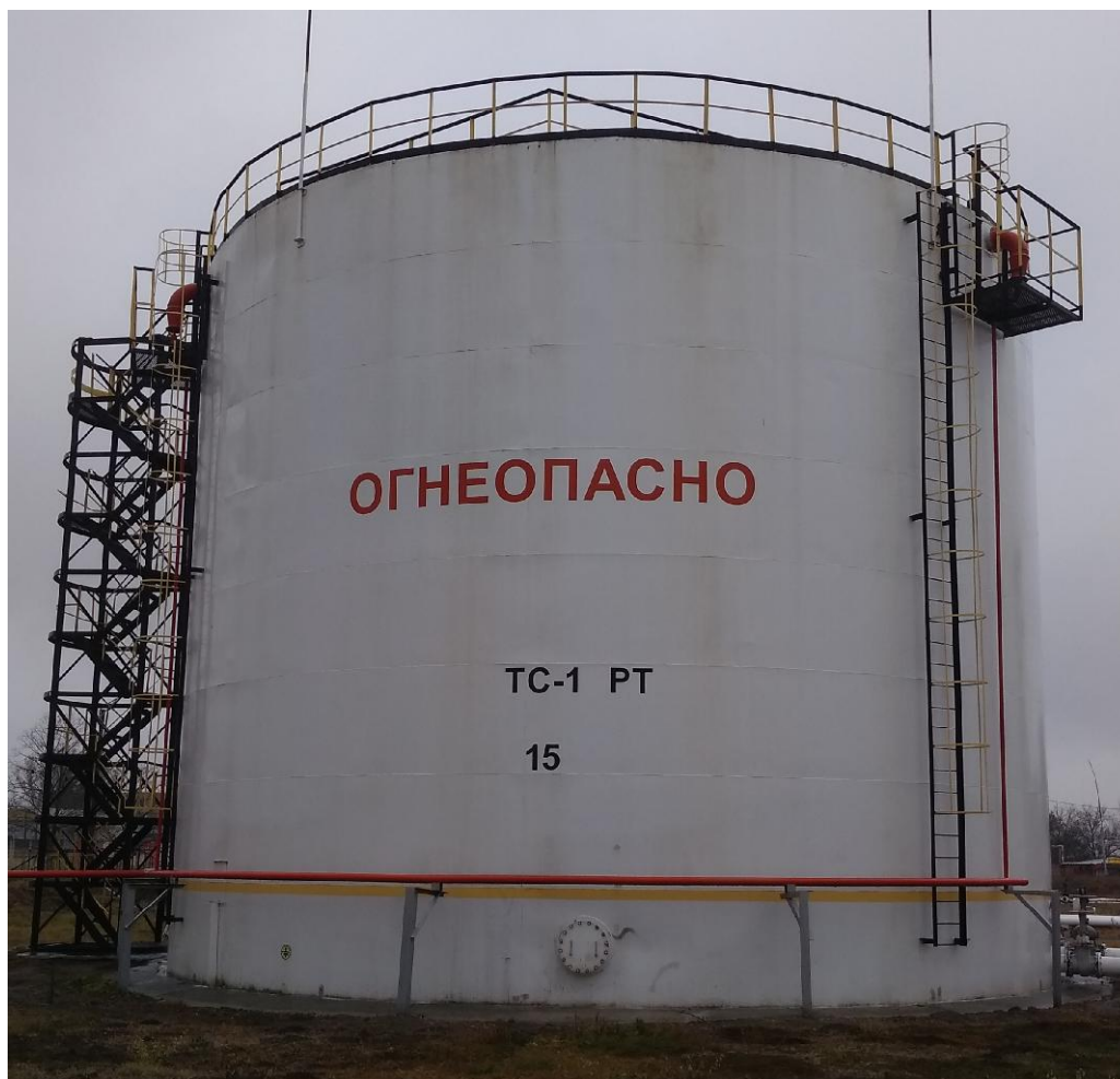
Рисунок 1 - Общий вид резервуара стального вертикального цилиндрического РВС-2000
