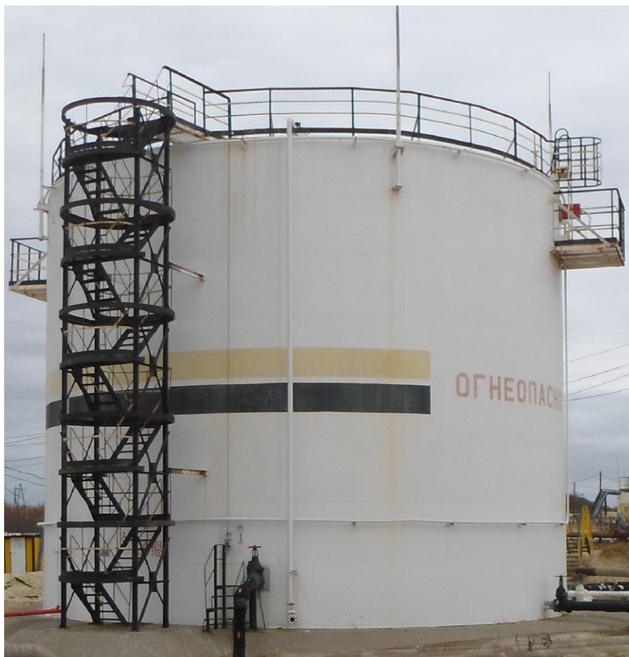
Рисунок 1 - Общий вид резервуара стального вертикального цилиндрического РВС-2000
