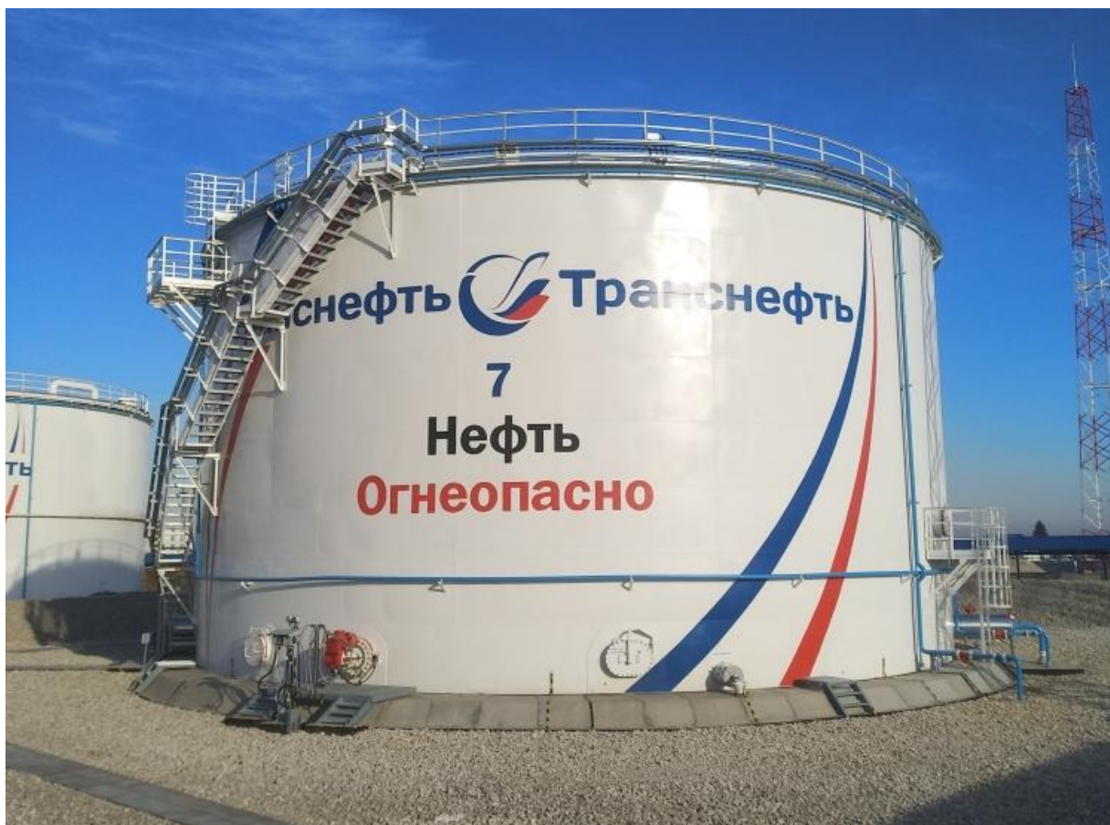
Рисунок 1 - Общий вид резервуара РВСП-5000
