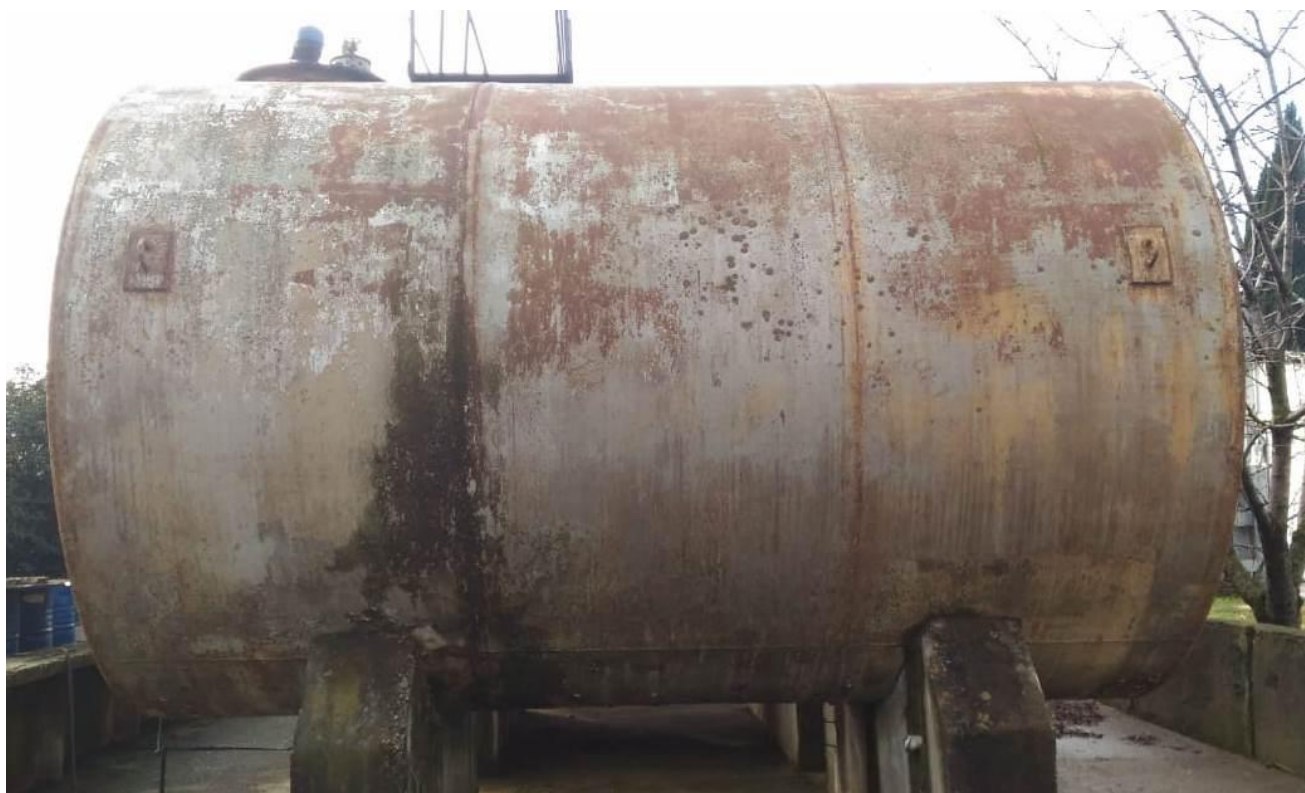
Рисунок 1 - Общий вид резервуара стального горизонтального цилиндрического РГС-25
