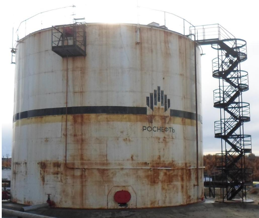
Рисунок 1 - Общий вид резервуара стального вертикального цилиндрического РВС-2000
