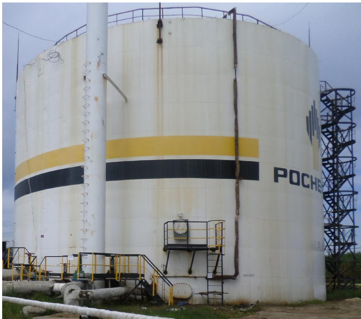
Рисунок 2 - Общий вид резервуара стального вертикального цилиндрического РВС-5000
