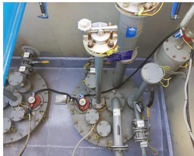
Рисунок 6 - Общий вид видимой части конструкции резервуаров РГС-50 № 2011, 2012
