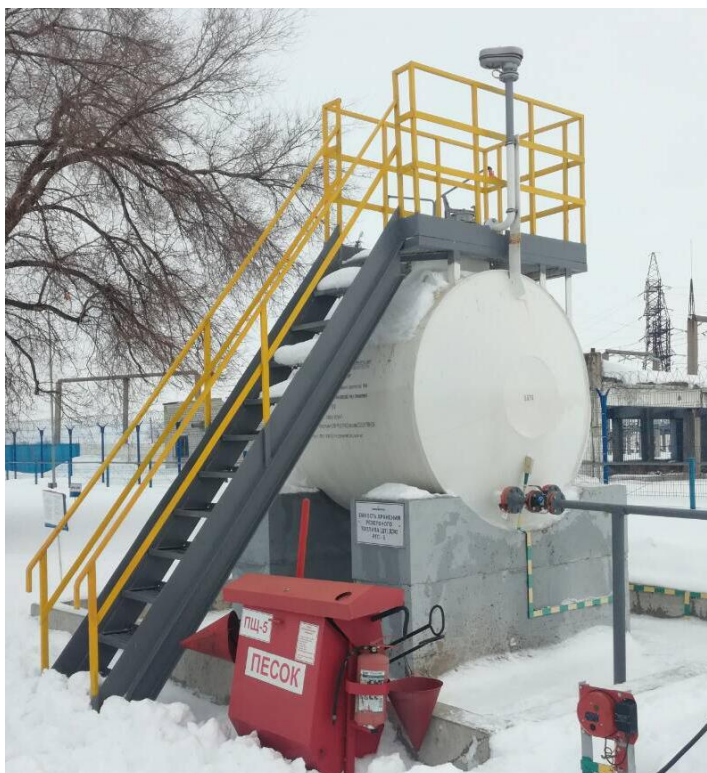
Рисунок 1 - Общий вид резервуара
