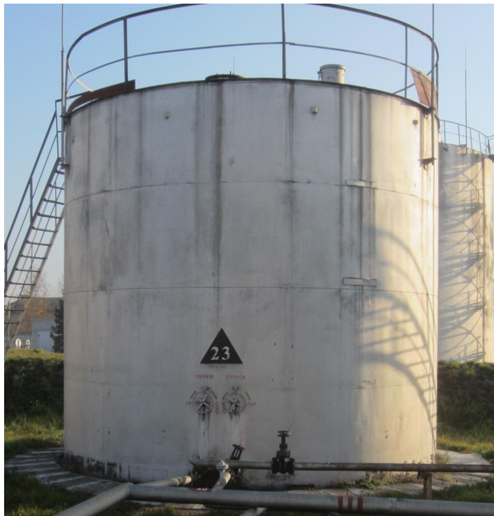
Рисунок 1 - Общий вид резервуара стального вертикального цилиндрического РВС-200
