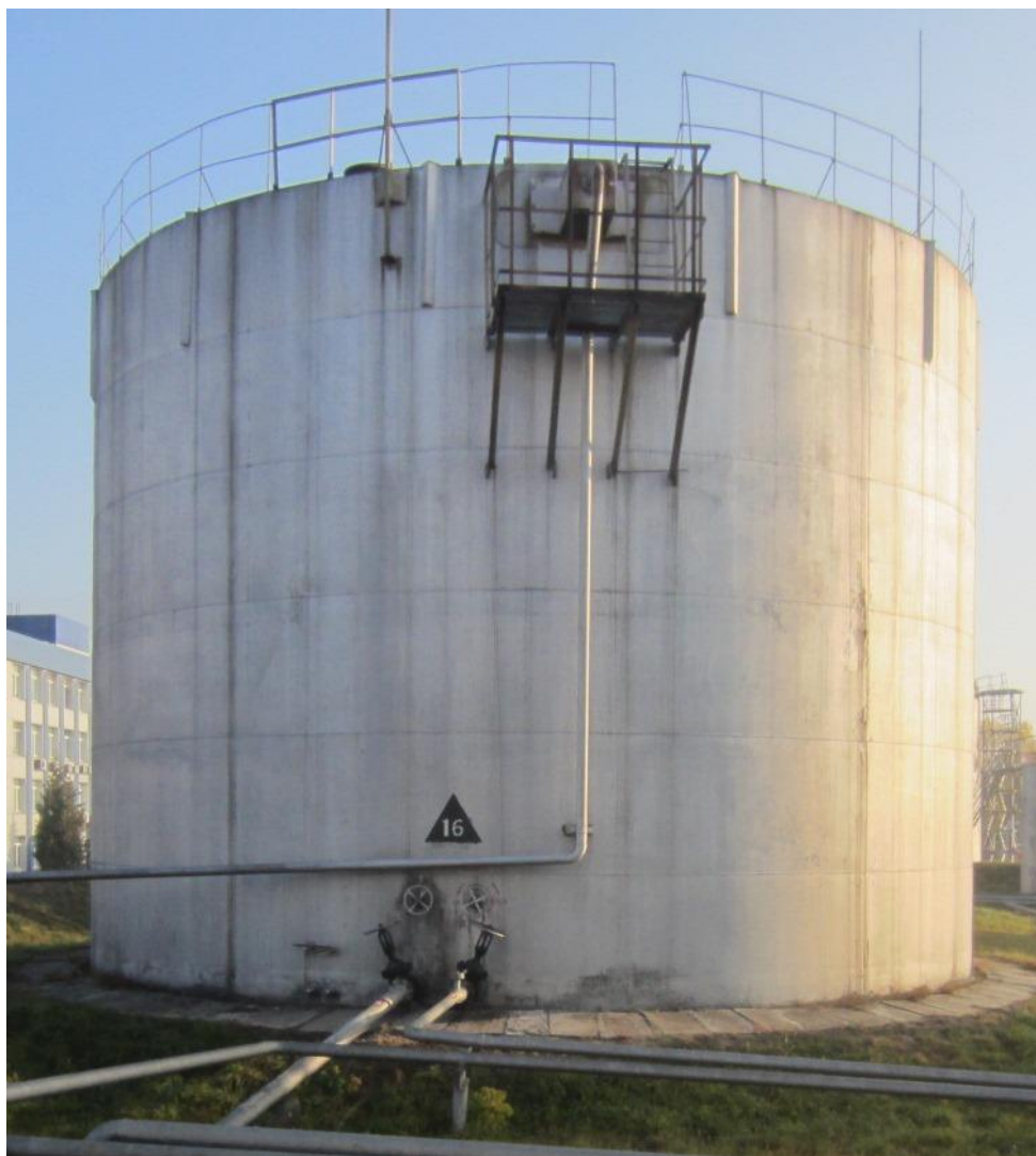
Рисунок 2 - Общий вид резервуара стального вертикального цилиндрического РВС-1000
