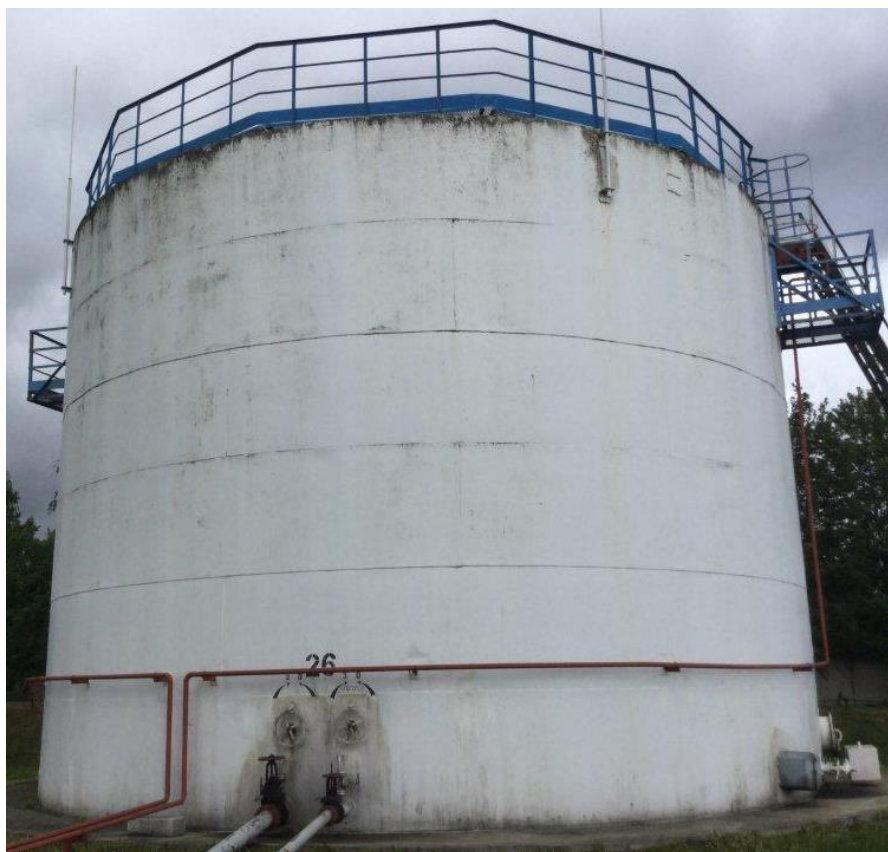
Рисунок 4 - Общий вид резервуара стального вертикального цилиндрического РВС-1000
