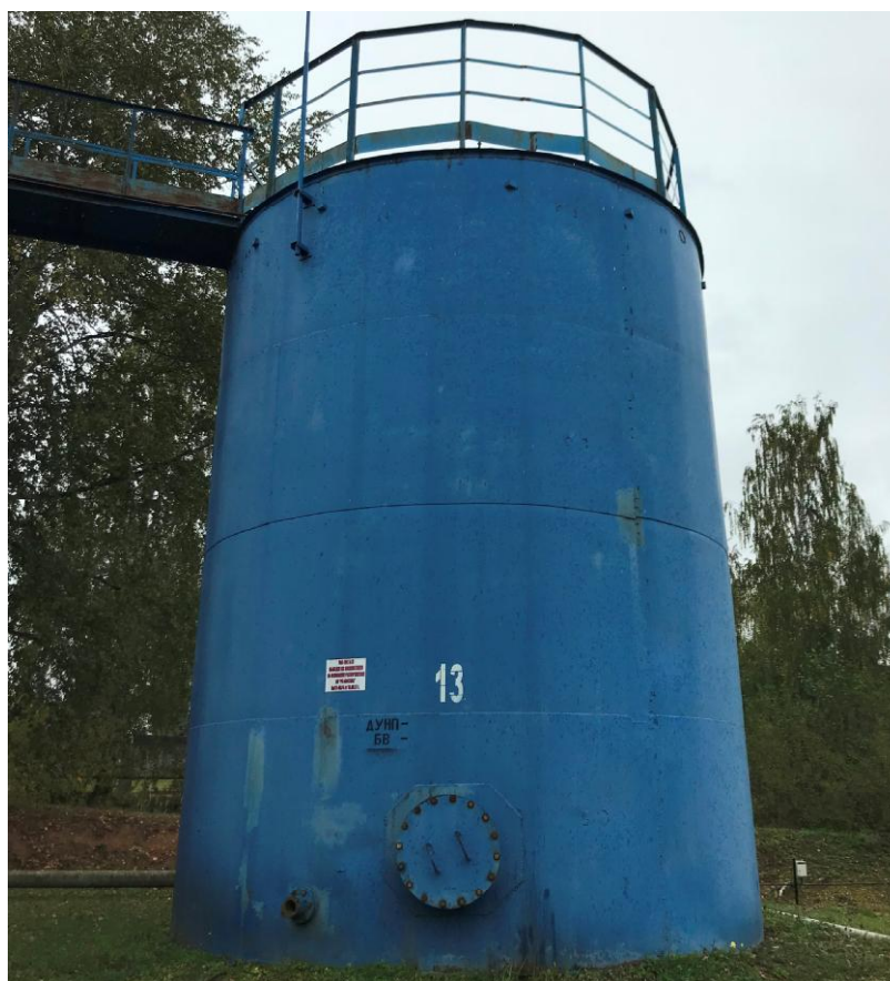
Рисунок 1 - Общий вид резервуара стального вертикального цилиндрического РВС-100
