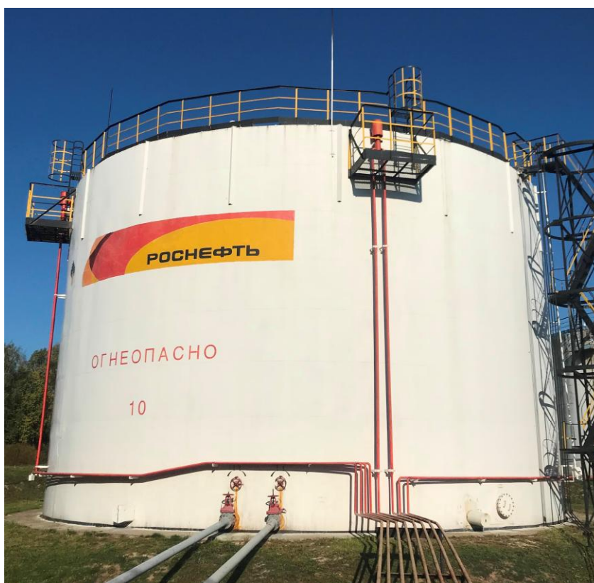
Рисунок 7 - Общий вид резервуара стального вертикального цилиндрического РВСП-3000
