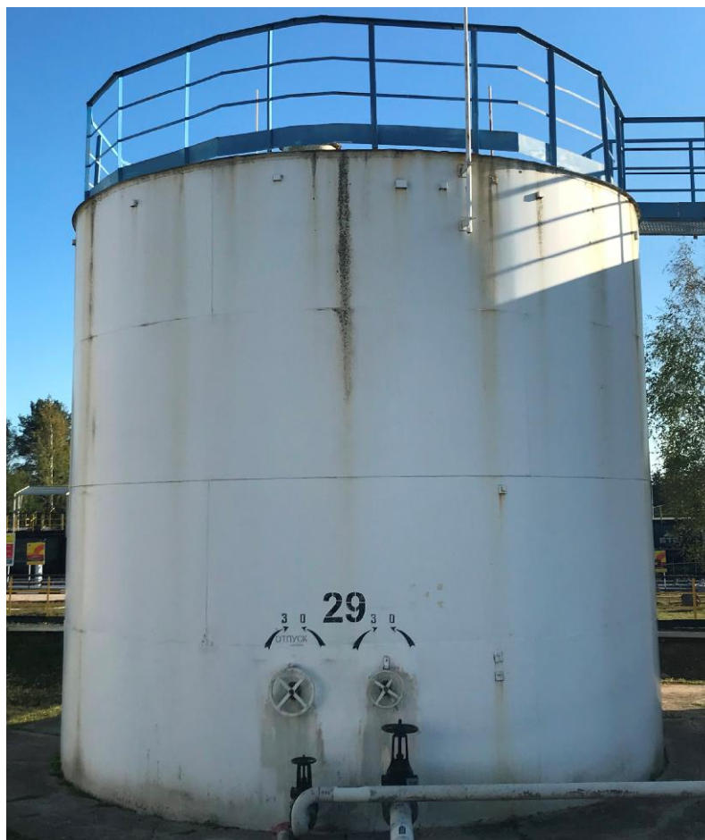
Рисунок 2 - Общий вид резервуара стального вертикального цилиндрического РВС-200
