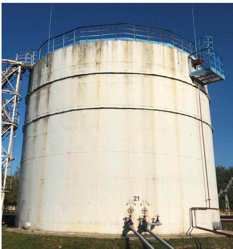
Рисунок 5 - Общий вид резервуара стального вертикального цилиндрического РВС-2000
