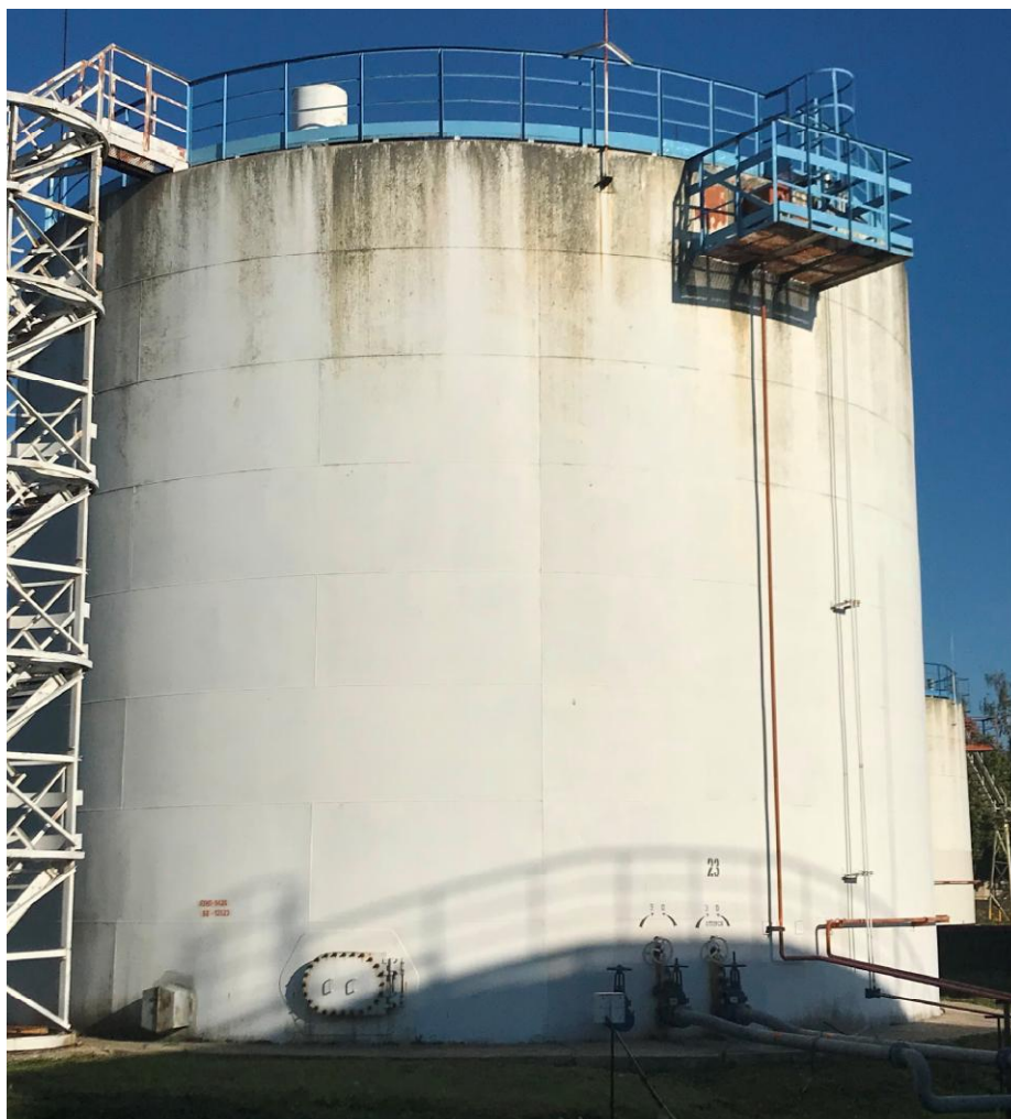
Рисунок 1 - Общий вид резервуара стального вертикального цилиндрического РВСП-2000
