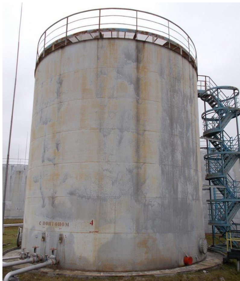
Рисунок 1 - Общий вид резервуара стального вертикального цилиндрического РВС-900
