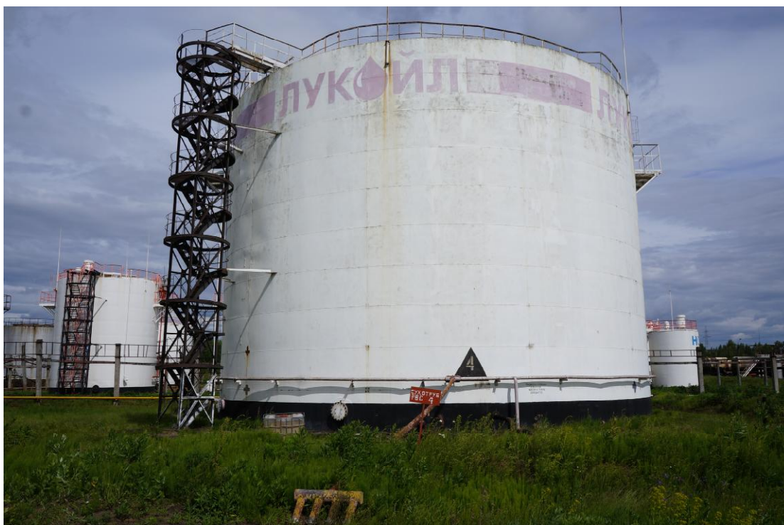
Рисунок 1 - Общий вид резервуара стального вертикального цилиндрического РВС-5000
