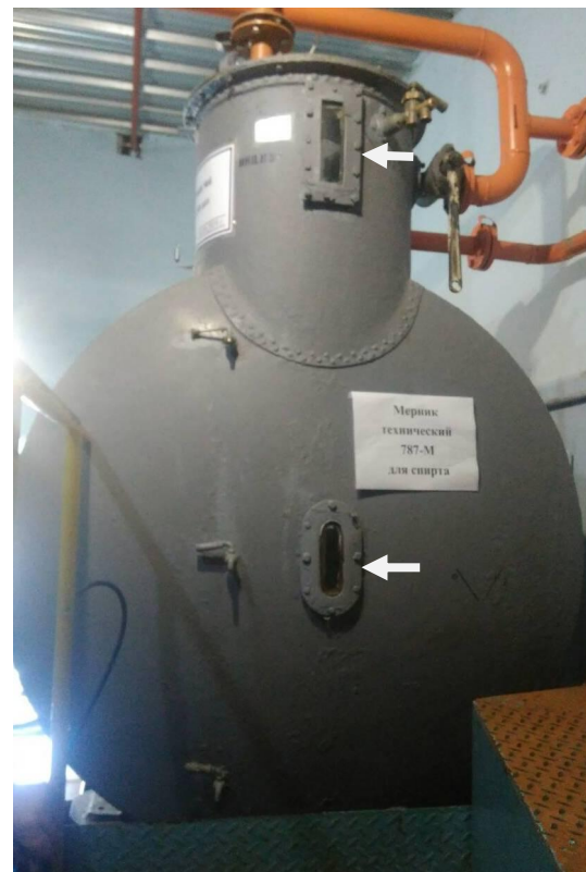
Рисунок 2а - Схема обозначение места нанесения знака поверки мерников 787-М зав. №№ 1, 2, 6, 7
