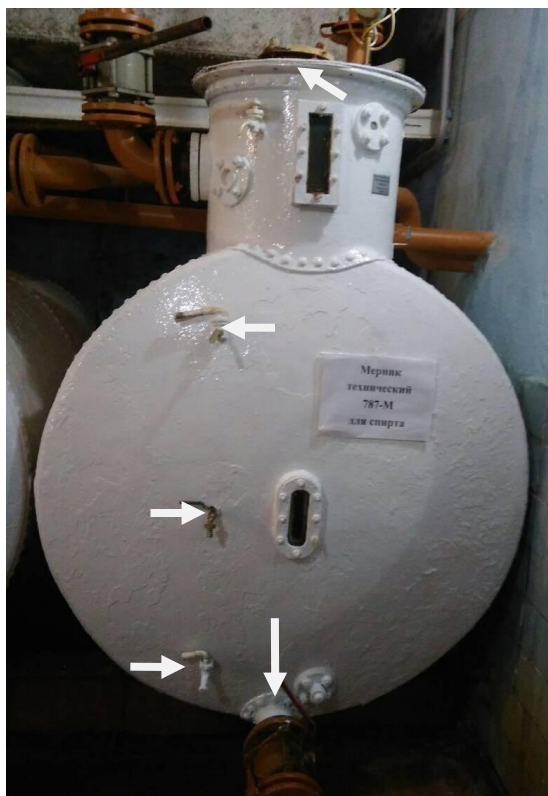
Рисунок 2б - Схема пломбировки мерников 787-М зав.№№ 1, 2, 6, 7 от несанкционированного доступа
