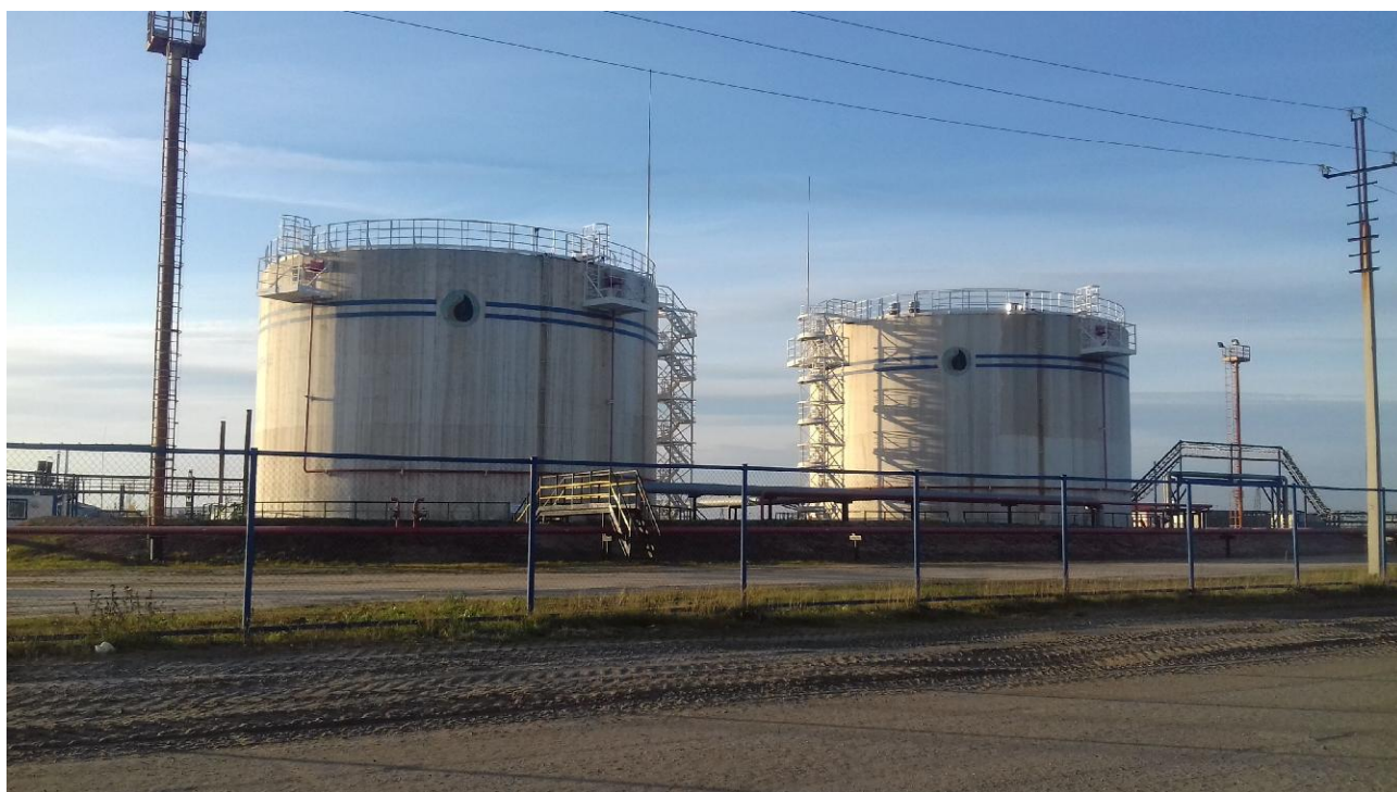
Рисунок 1 - Общий вид резервуаров РВС-3000
