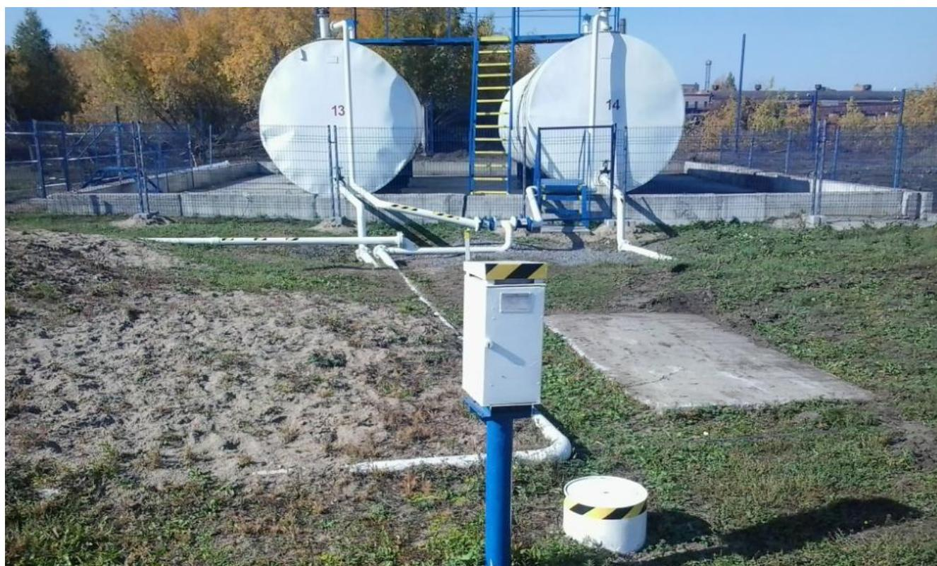
Рисунок 1 - Общий вид резервуаров горизонтальных стальных цилиндрических РГС-100
