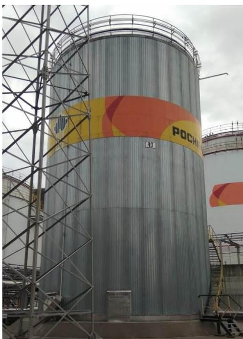
Рисунок 1 - Общий вид резервуара РВС-2000
