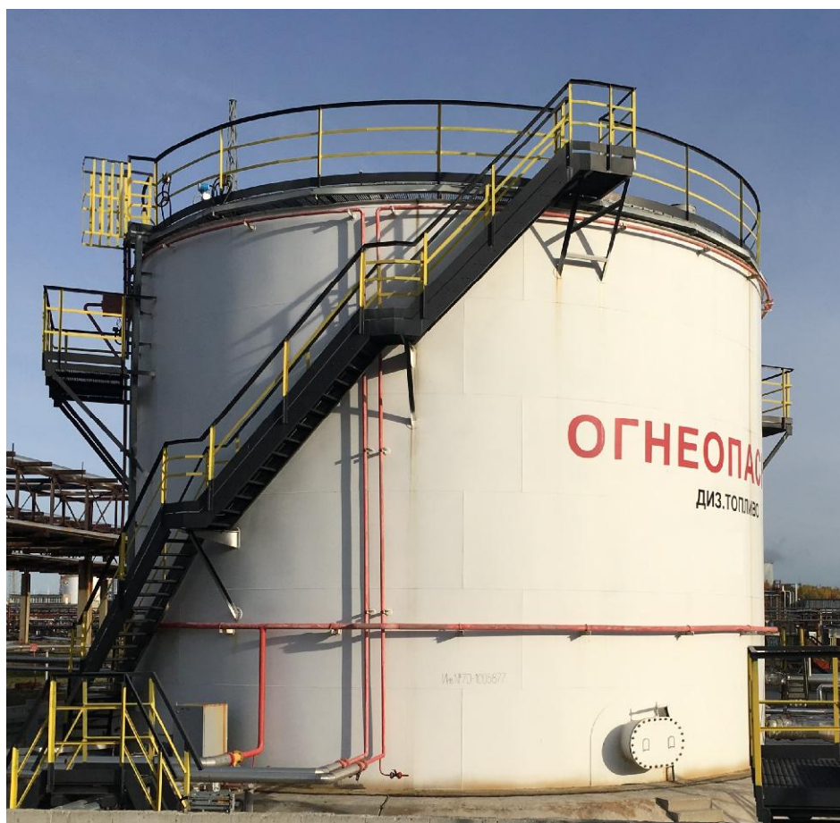
Рисунок 1 - Общий вид резервуара стального вертикального цилиндрического РВС-1000
