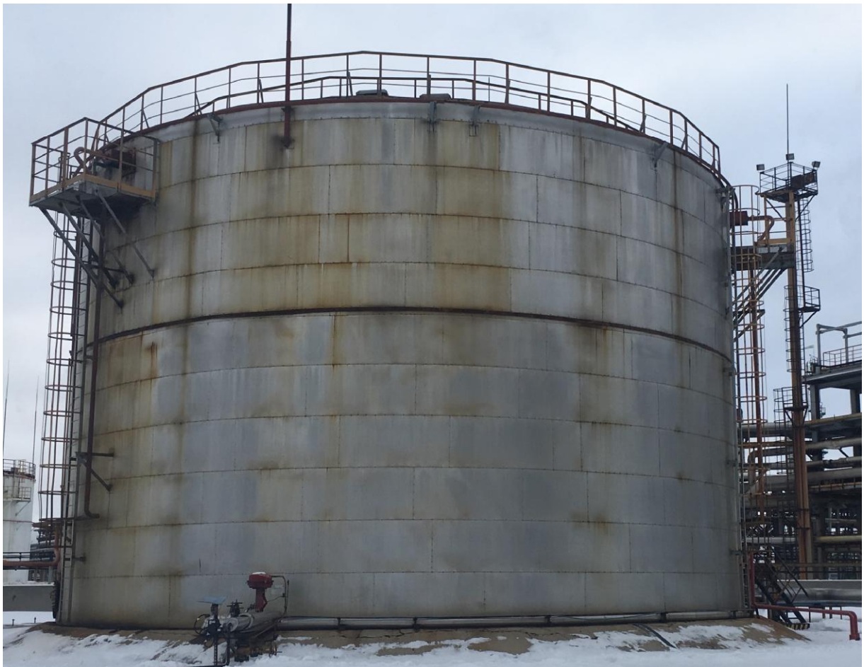
Рисунок 1 - Общий вид резервуара стального вертикального цилиндрического РВС-3000
