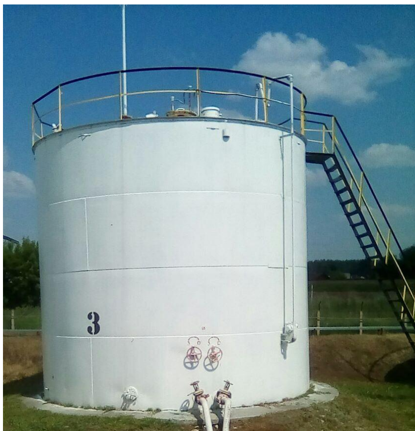
Рисунок 1 - Общий вид резервуара стального вертикального цилиндрического РВС-200
