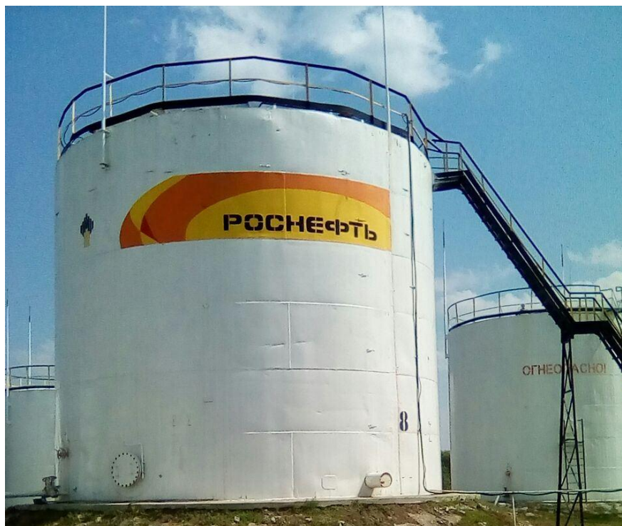
Рисунок 2 - Общий вид резервуара стального вертикального цилиндрического РВС-700
