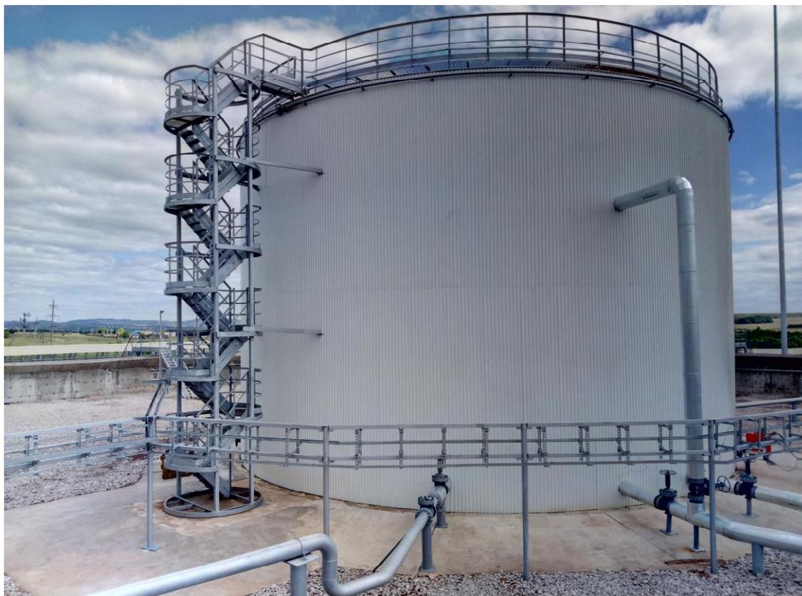
Рисунок 1 - Общий вид резервуара стального вертикального цилиндрического РВС-3000
