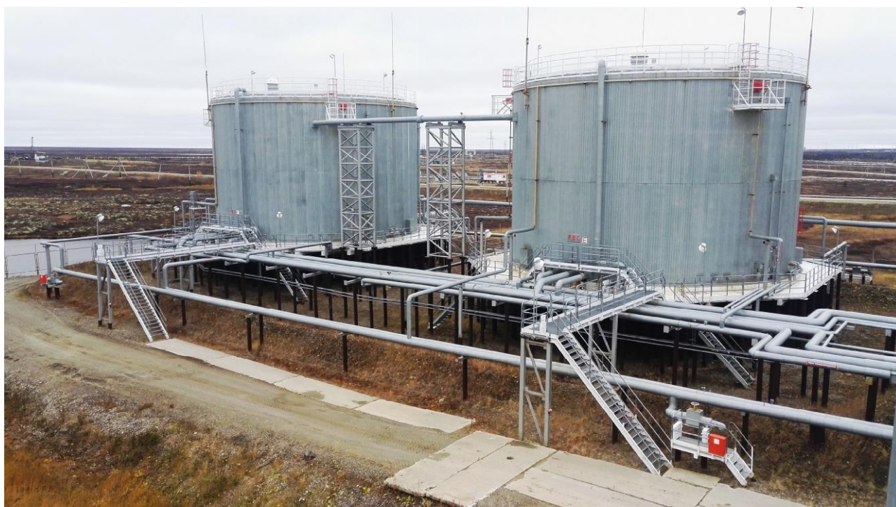
Рисунок 1 - Общий вид резервуаров РВС-3000
