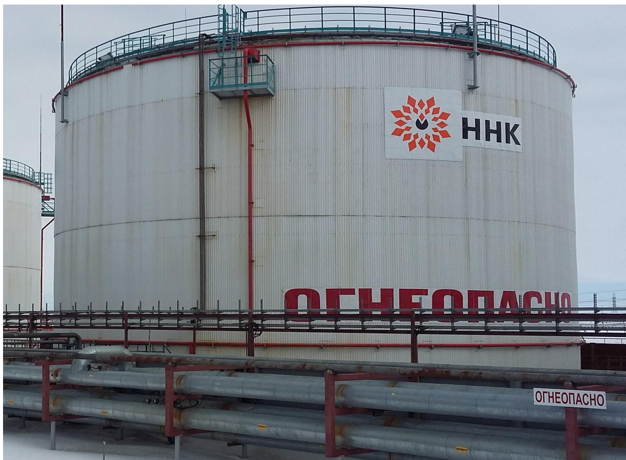
Рисунок 1 - Общий вид резервуара РВС-10000
