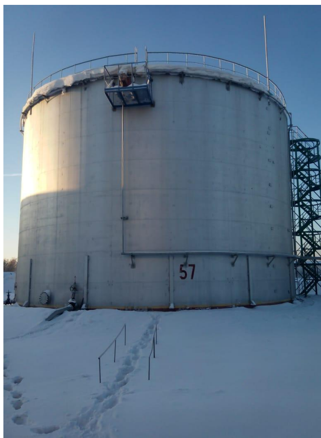
Рисунок 3 - Общий вид резервуара вертикального стального цилиндрического РВС-3000
