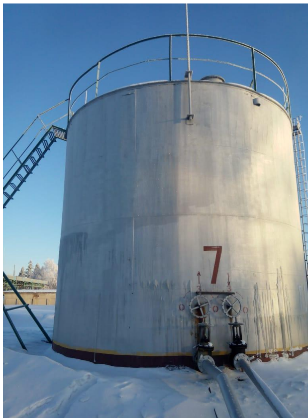
Рисунок 1 - Общий вид резервуара вертикального стального цилиндрического РВС-200
