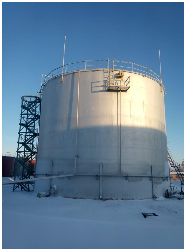
Рисунок 2 - Общий вид резервуара вертикального стального цилиндрического РВС-2000
