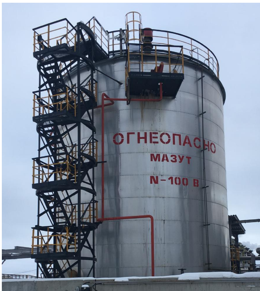
Рисунок 1 - Общий вид резервуара стального вертикального цилиндрического РВС-1000
