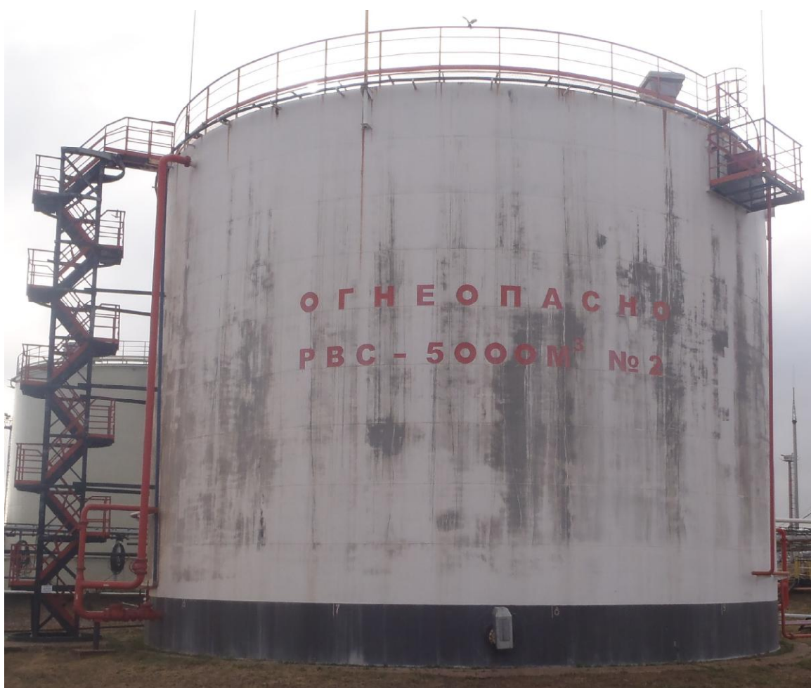
Рисунок 1 - Общий вид резервуара стального вертикального цилиндрического РВС-5000
