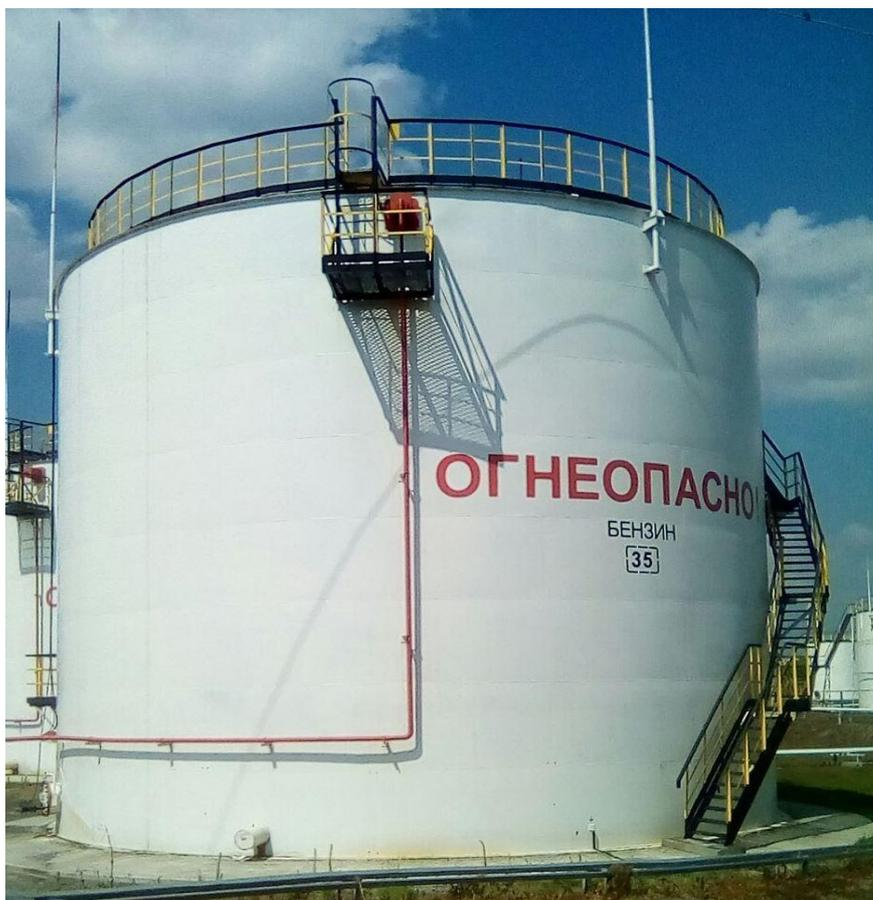
Рисунок 1 - Общий вид резервуара стального вертикального цилиндрического РВС-2000
