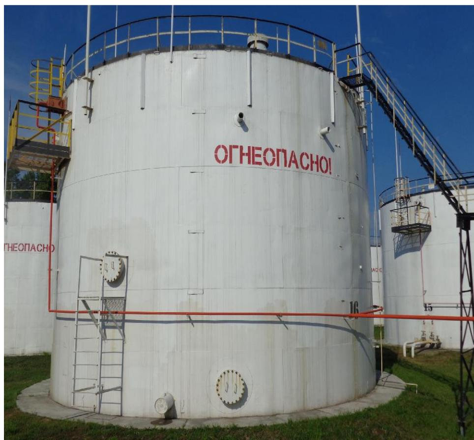
Рисунок 2 - Общий вид резервуара стального вертикального цилиндрического РВС-5000
