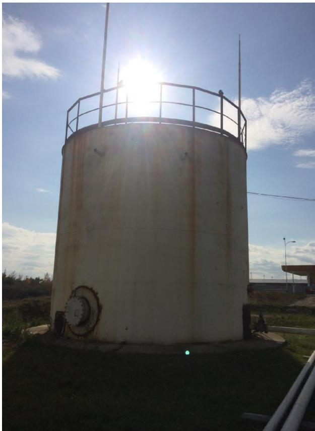
Рисунок 1 - Общий вид резервуара стального вертикального цилиндрического РВС-200
