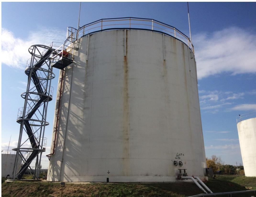
Рисунок 4 - Общий вид резервуара стального вертикального цилиндрического РВС-2000
