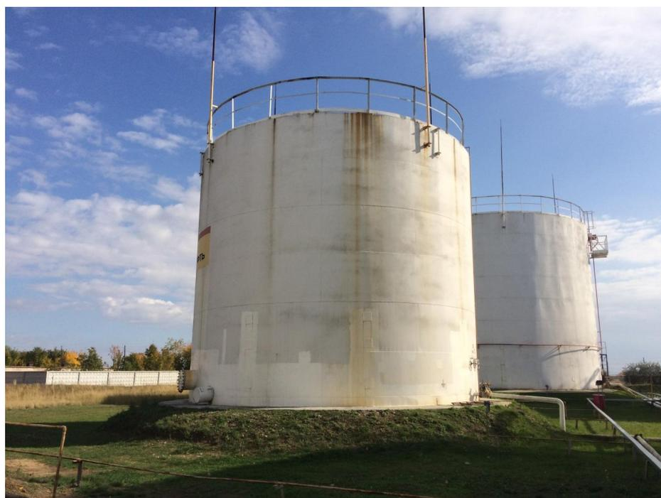
Рисунок 3 - Общий вид резервуара стального вертикального цилиндрического РВС-700
