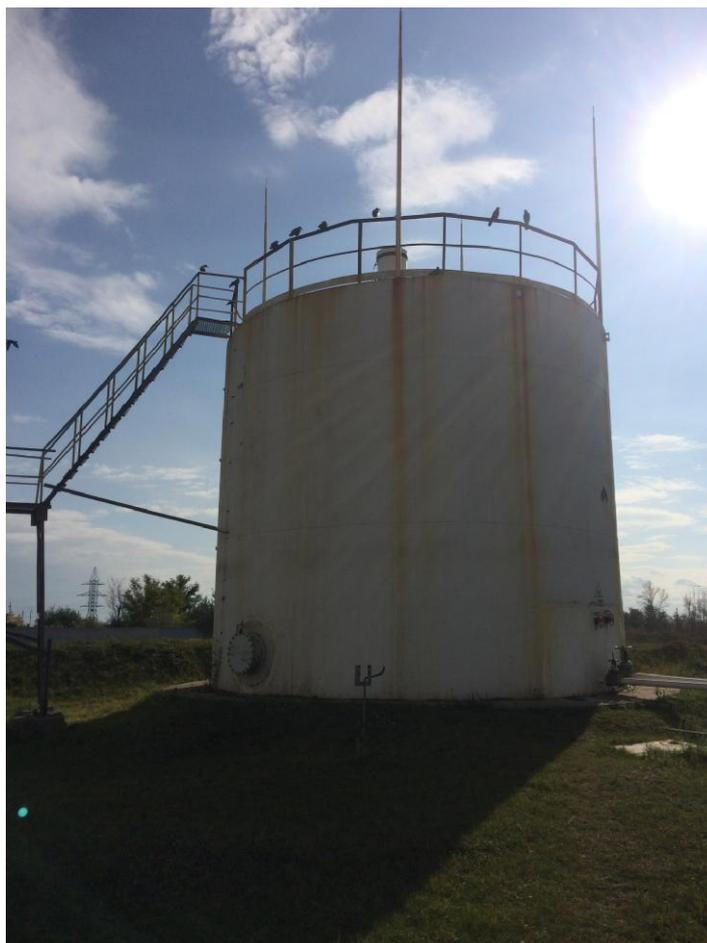
Рисунок 2 - Общий вид резервуара стального вертикального цилиндрического РВС-400
