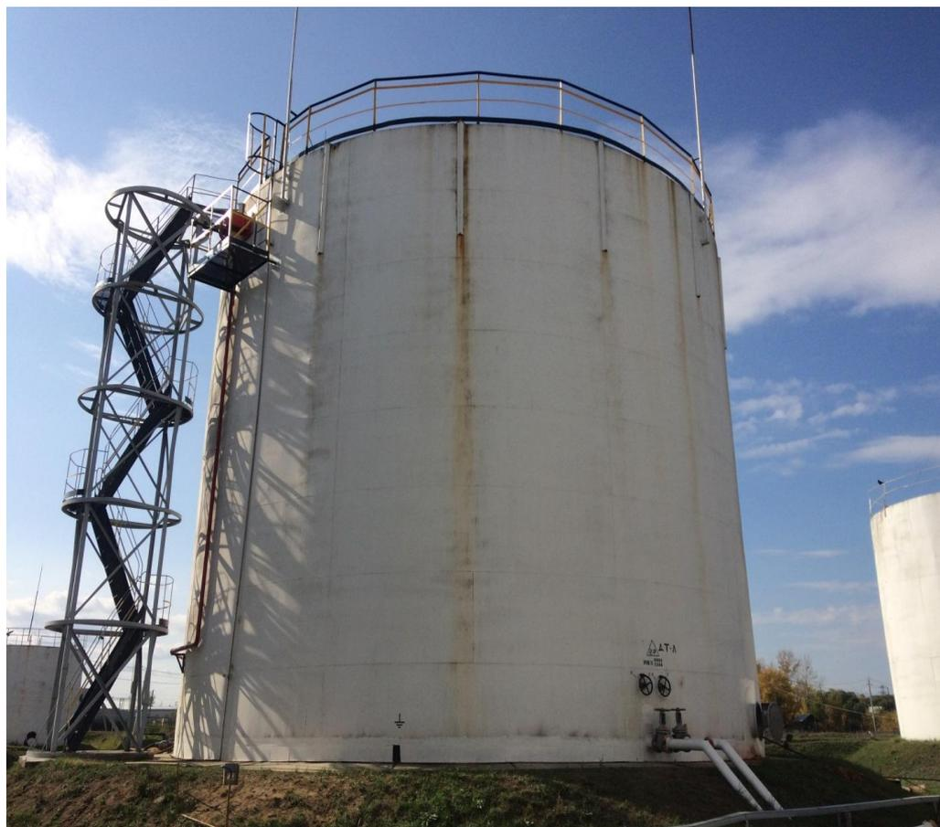
Рисунок 2 - Общий вид резервуара стального вертикального цилиндрического РВС-2000
