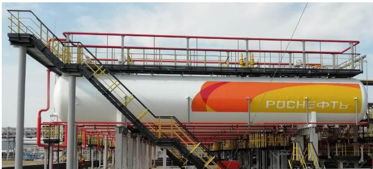
Рисунок 1 - Общий вид резервуара стального горизонтального цилиндрического РГС-200
