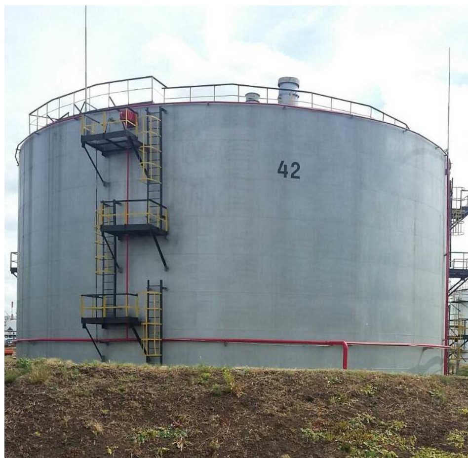
Рисунок 4 - Общий вид резервуара стального вертикального цилиндрического РВС-5000
