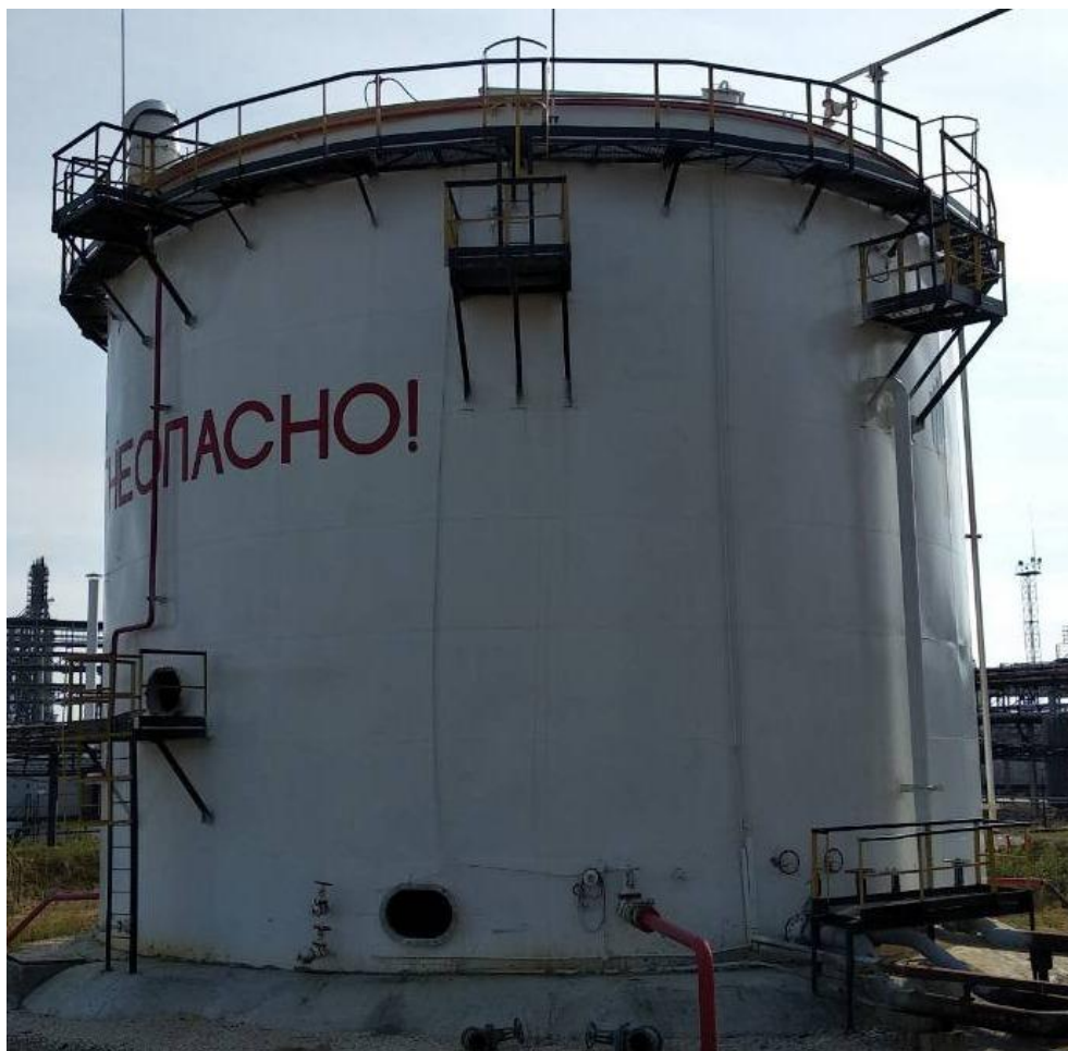
Рисунок 2 - Общий вид резервуара стального вертикального цилиндрического РВС-2000
