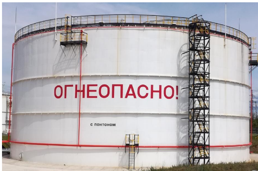
Рисунок 6 - Общий вид резервуара стального вертикального цилиндрического PVC-20000
