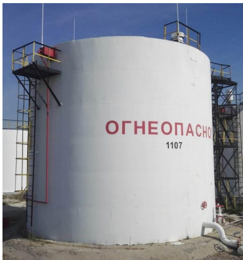
Рисунок 1 - Общий вид резервуара стального вертикального цилиндрического РВС-700
