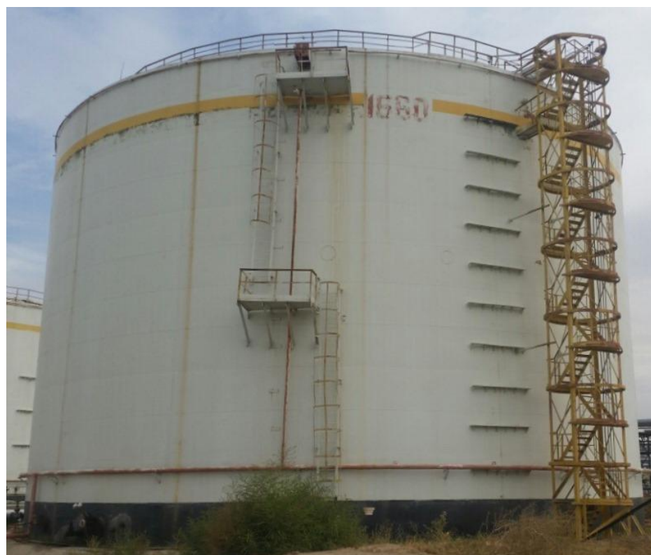
Рисунок 5 - Общий вид резервуара стального вертикального цилиндрического РВС-10000
