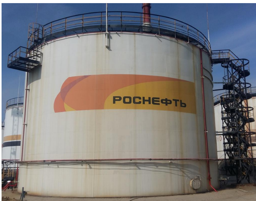
Рисунок 3 - Общий вид резервуара стального вертикального цилиндрического РВС-3000
