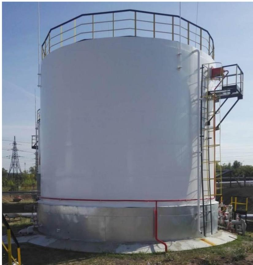
Рисунок 2 - Общий вид резервуара стального вертикального цилиндрического РВС-700
