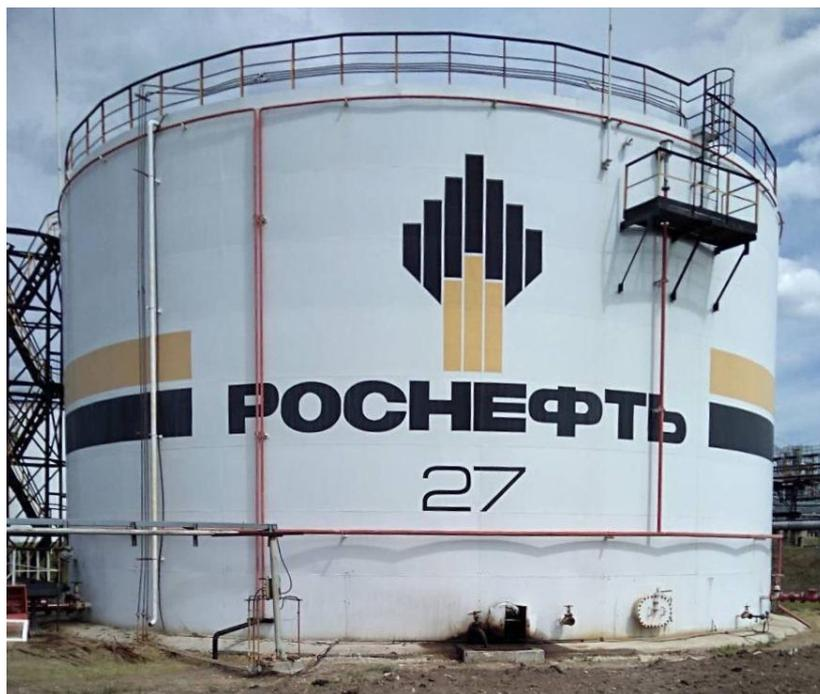
Рисунок 4 - Общий вид резервуара стального вертикального цилиндрического РВС-5000
