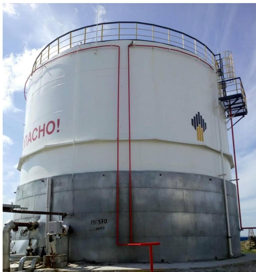
Рисунок 3 - Общий вид резервуара стального вертикального цилиндрического РВС-2000
