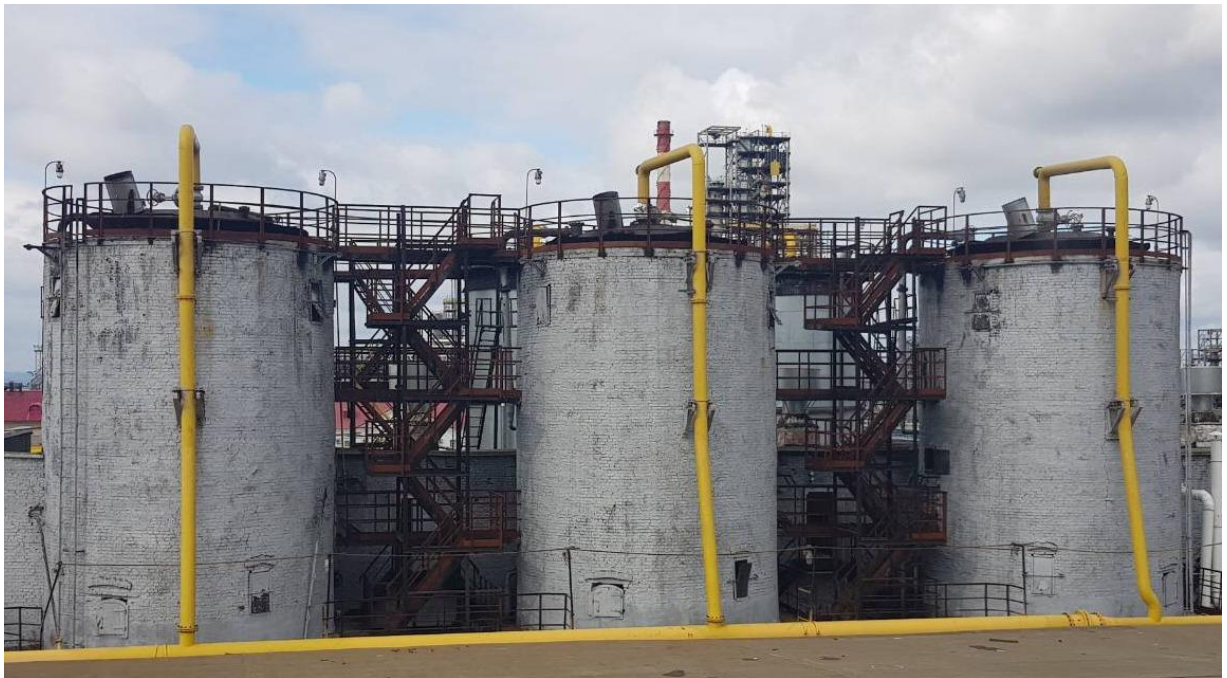
Рисунок 1 - Общий вид резервуара стального вертикального цилиндрического РВС-200
