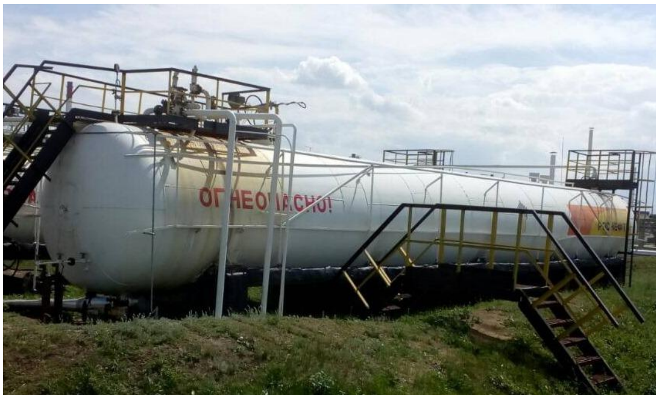
Рисунок 1 - Общий вид резервуара стального горизонтального цилиндрического РГС-200
