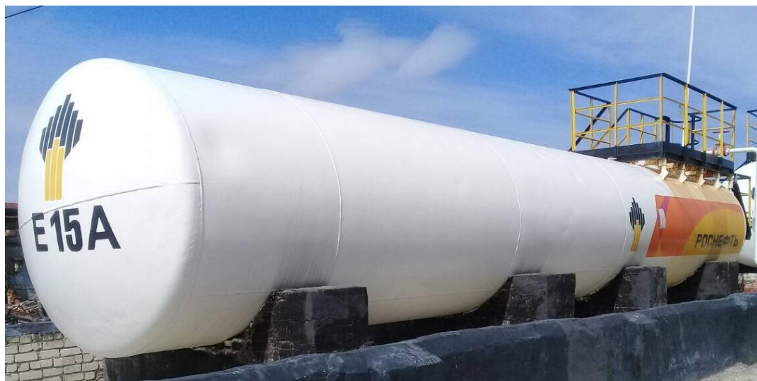
Рисунок 1 - Общий вид резервуара стального горизонтального цилиндрического РГС-50
