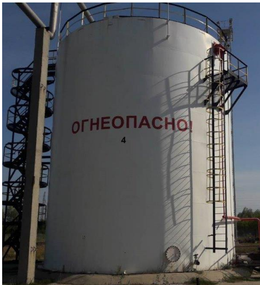
Рисунок 1 - Общий вид резервуара стального вертикального цилиндрического РВС-1000
