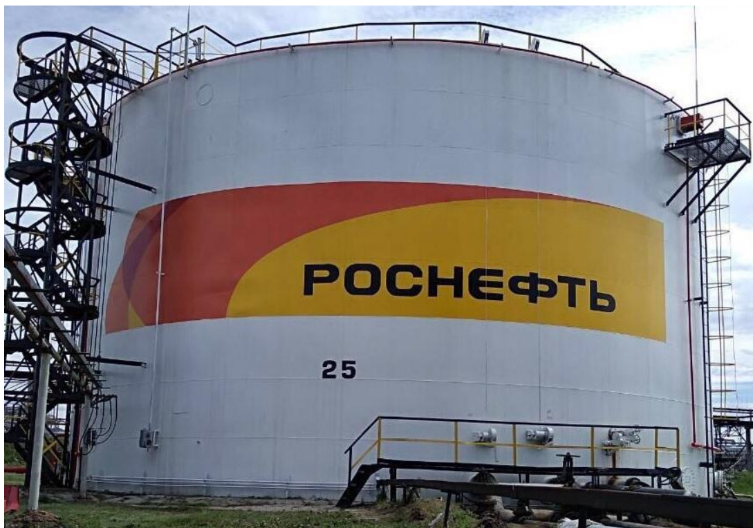
Рисунок 2 - Общий вид резервуара стального вертикального цилиндрического РВС-5000
