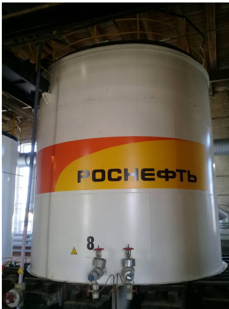
Рисунок 1 - Общий вид резервуара стального вертикального цилиндрического РВС-200
