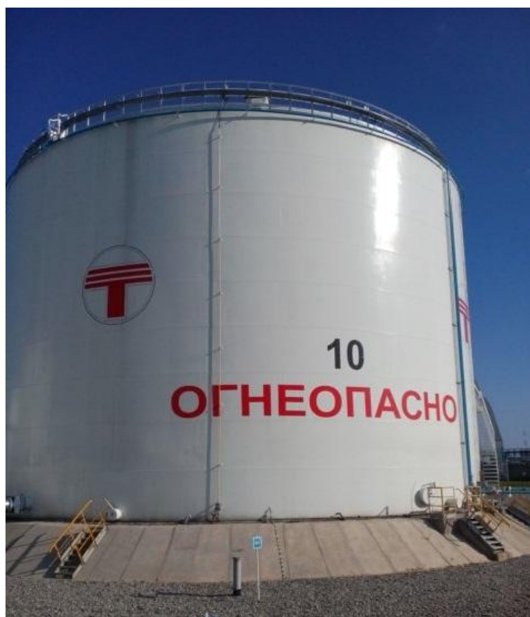
Рисунок 2 - Общий вид резервуаров вертикальных стальных цилиндрических РВС-10000
