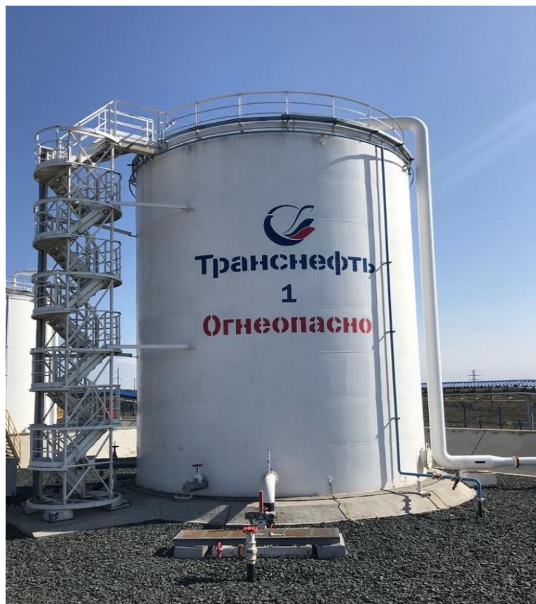
Рисунок 1 - Общий вид резервуаров вертикальных стальных цилиндрических РВС-1000
