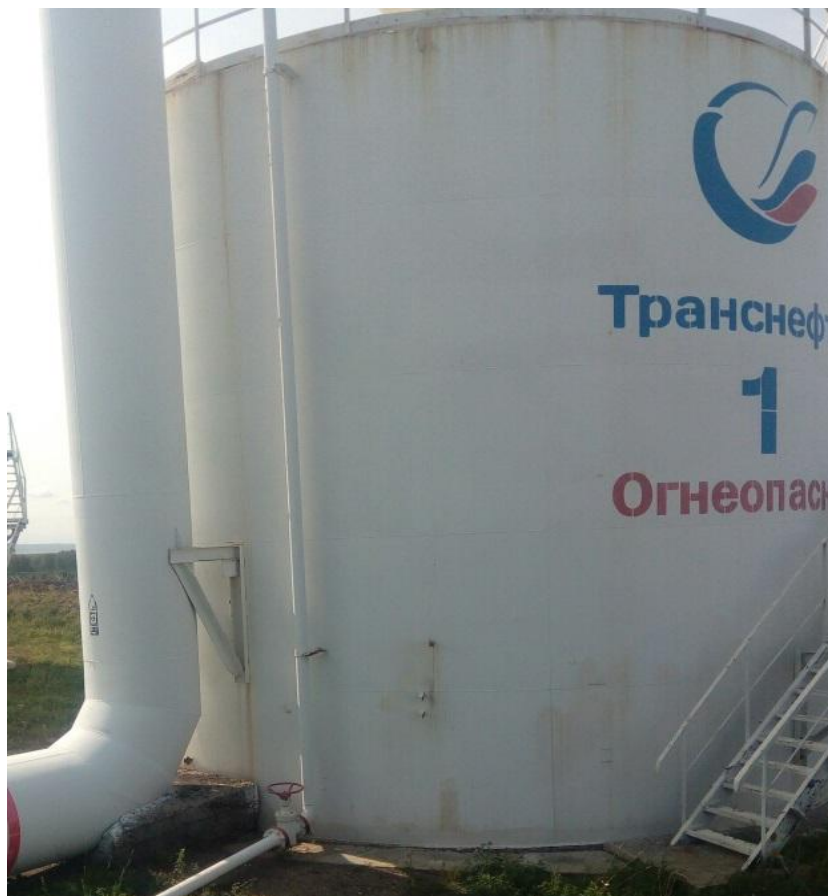
Рисунок 1 - Общий вид резервуаров вертикальных стальных цилиндрических РВС-400
