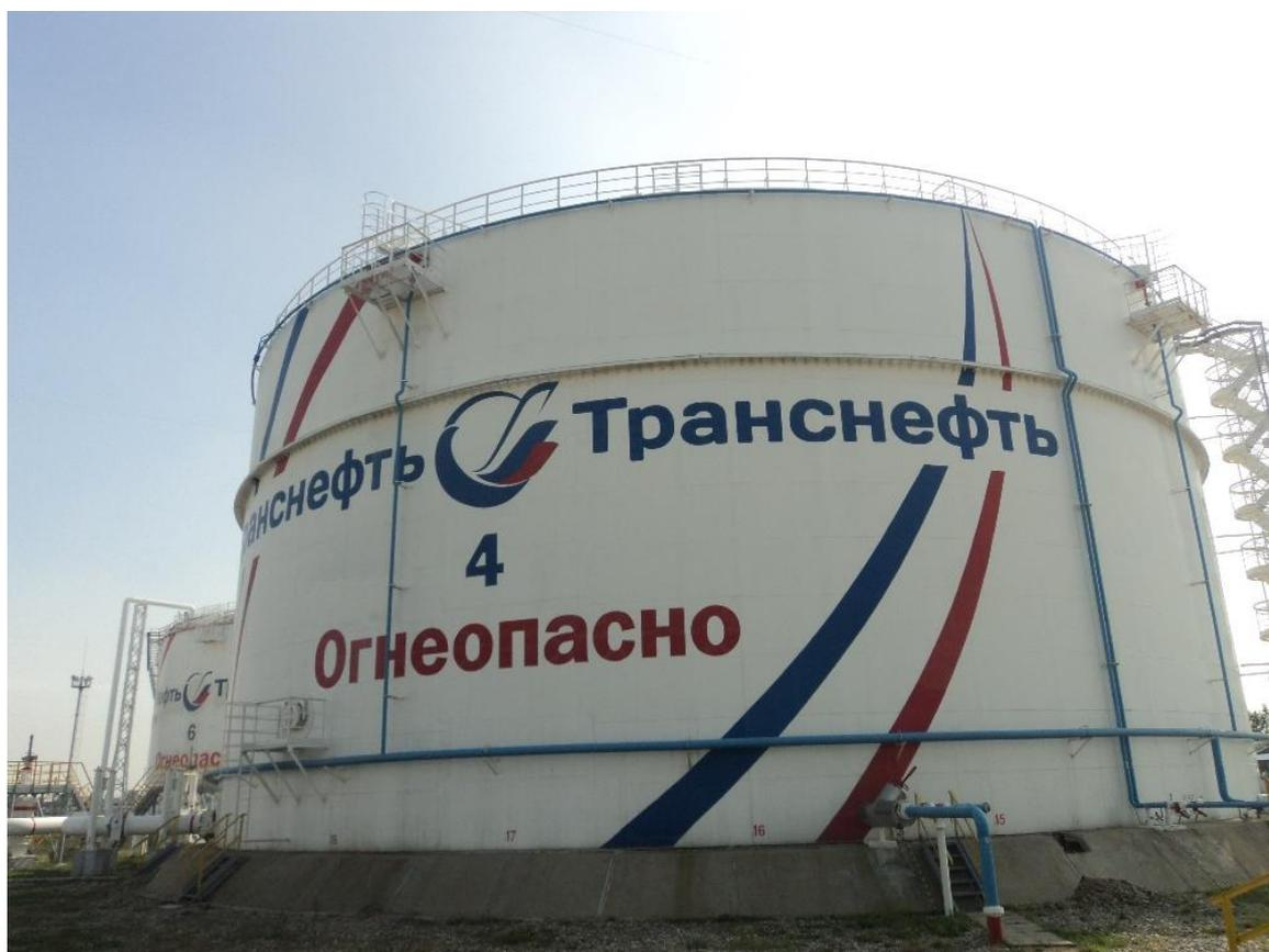
Рисунок 2 - Общий вид резервуаров вертикальных стальных цилиндрических РВСП-20000
