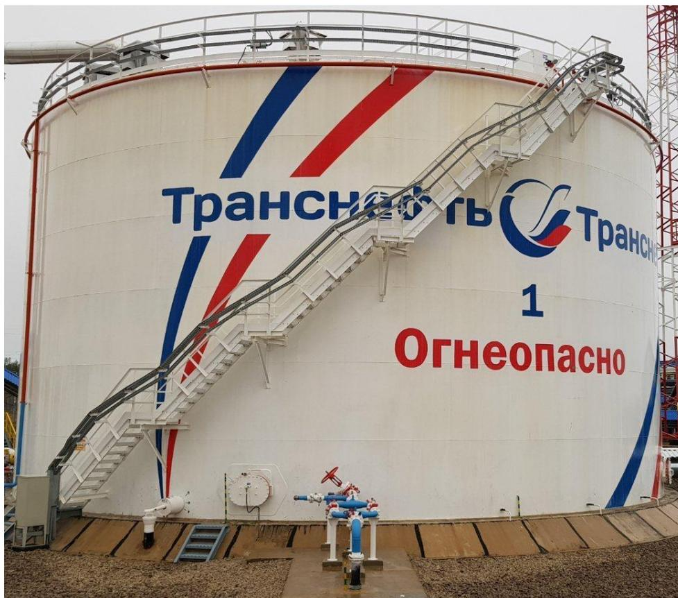
Рисунок 1 - Общий вид резервуаров вертикальных стальных цилиндрических РВС-5000
