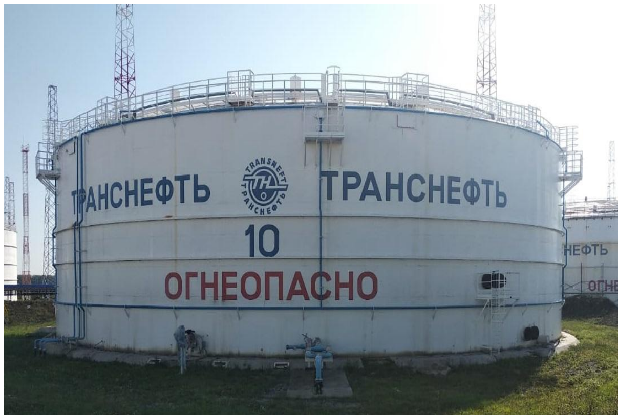
Рисунок 4 - Общий вид резервуаров вертикальных стальных цилиндрических РВСП-20000
