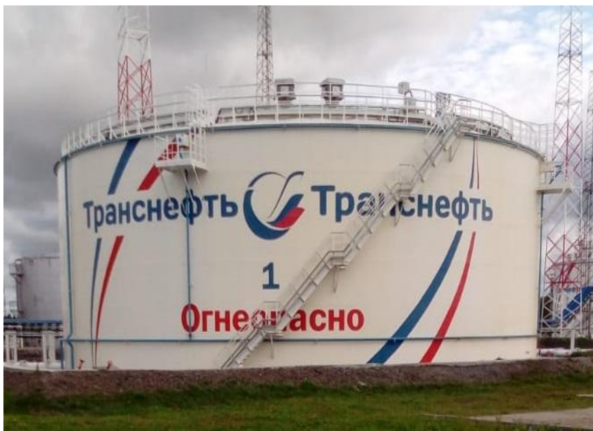
Рисунок 2 - Общий вид резервуаров вертикальных стальных цилиндрических РВС-10000
