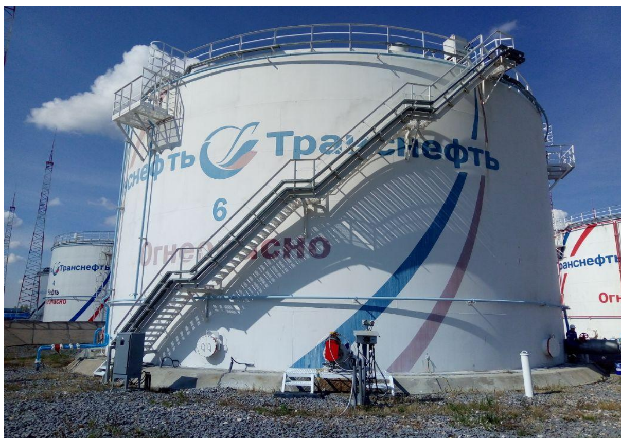
Рисунок 3 - Общий вид резервуаров вертикальных стальных цилиндрических РВСП-5000
