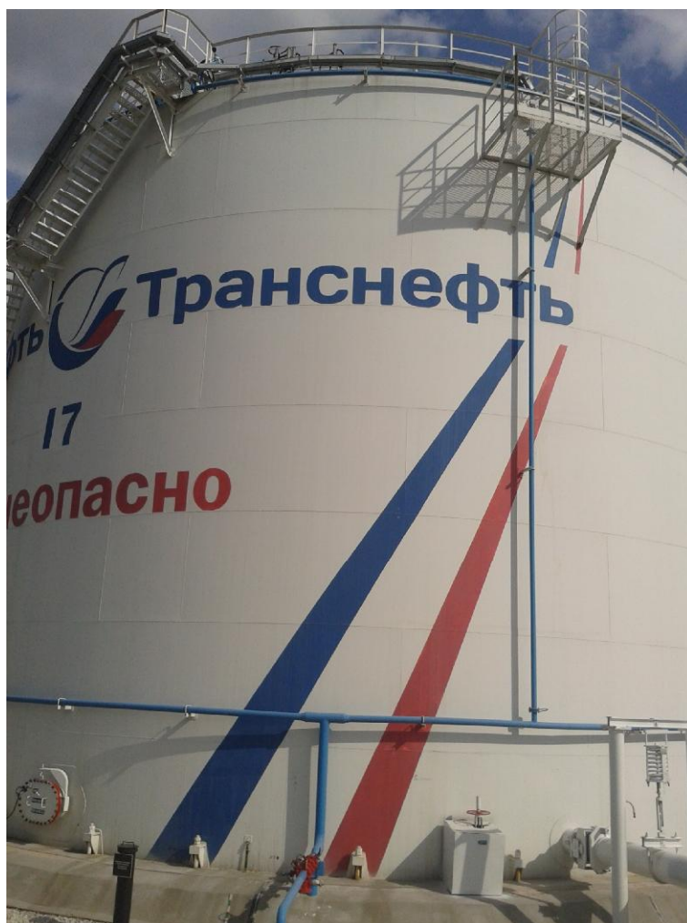
Рисунок 1 - Общий вид резервуаров вертикальных стальных цилиндрических РВС-5000
