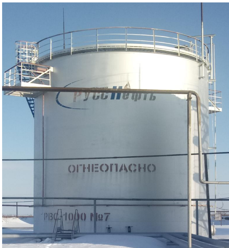
Рисунок 1 - Резервуар вертикальный стальной РВС-1000
