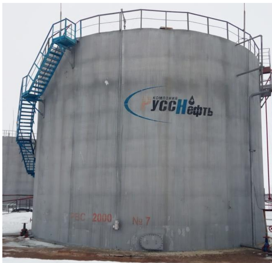
Рисунок 2 - Резервуар вертикальный стальной РВС-2000
