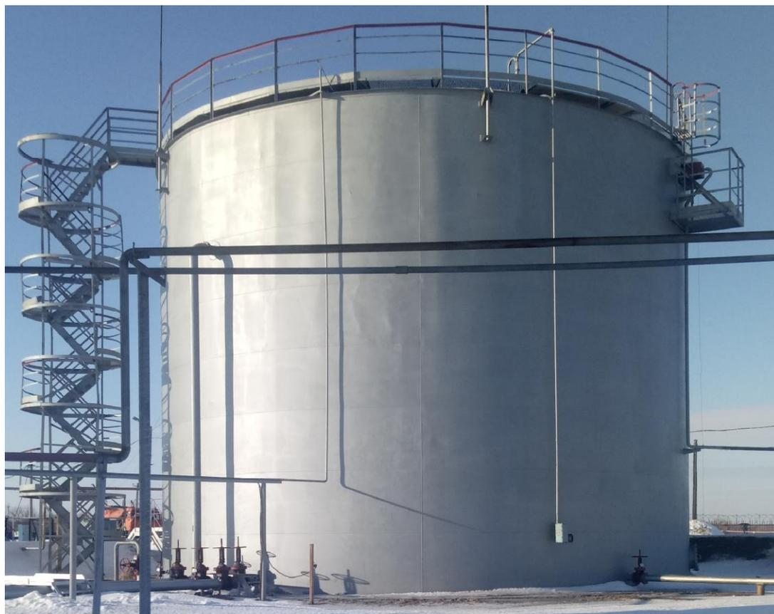
Рисунок 1 - Резервуар вертикальный стальной РВС-2000
